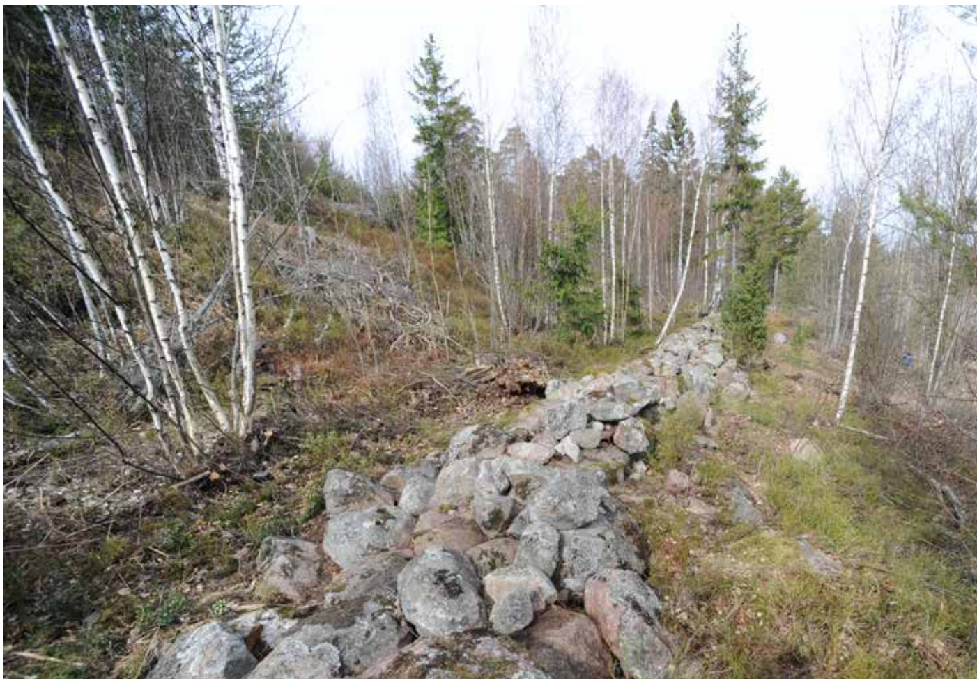
Kuva 7. Kukolan kiviaidan pääliosian rakenne S. Huhtikuu 2014. K.Uotila / Muuritutkimus.
