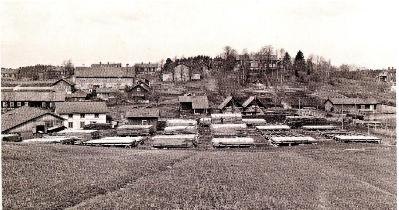
Kuva 1. Ruukinalue kuvattuna idästä 1910-luvulla. Kuvassa vasemmalla uusi saha ja lautatarha. Sahan vieressä oleva vaalea rakennus on mylly. Kuvan keskivaiheilla jokirannassa on yhä nykyisin paikalla olevat hiiliuunit.
