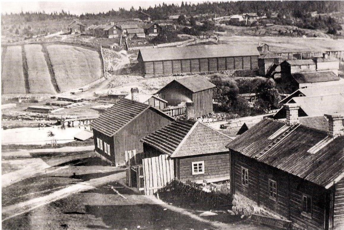
Kuva 2. Kuva 1880-luvulta. Etualalla ruukin työväenasuntoja, joen takana pitkä hiilihuone ja sen vierellä masuunin tuotantorakennuksia. Koskenrannalla mylly ja saha. Nykyinen laidunalueella säilytetään puutavaraa. Taustalla metsänrajassa on kaksi työväenasuntoa olevat hiiliuunit. Sahattua lautatavaraa keskellä.
