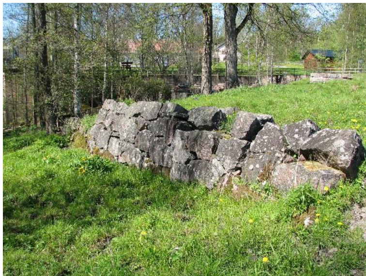
Kuva 8. Nuorimman saharakennuksen perutukset erottuvat yhä maastossa. Selkein jäännös on noin 1 m korkea luonnonkivistä tehty kivimuuri.
