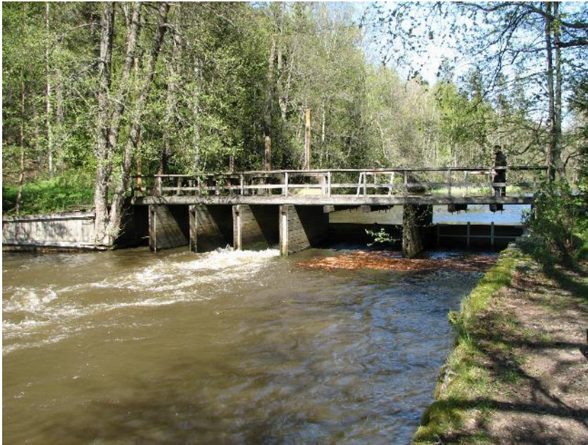
Kuva 18. Hålldamin padon rakenteita 25.5.2015.
