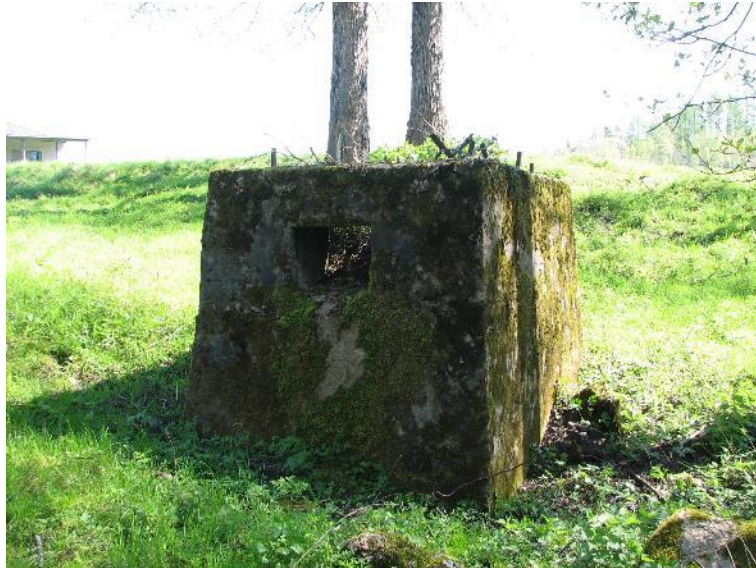
Kuva 7. Betonirakenne, todennäköisesti jonkin laitteen perustus.
