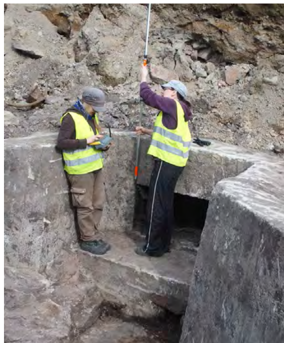
Kuva 4. Rakenteita dokumentoimassa Tuuli Heinonen ja Tiina Mikkonen.
