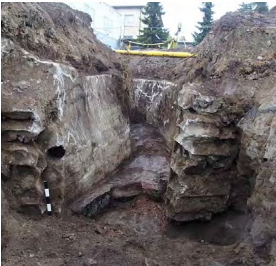
Kuva 44. Yhdyskäytävä kuvattuna suojahuoneesta päin.
