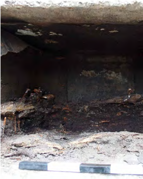
Kuva 13. Yksityiskohtakuva. Itäisen tuliaseman ampumasyvennyksen ampumatarvikekomeron sisällä on säilynyt tervapahvivuoraus sekä jäänteitä nauloilla kiinnitetystä puutasosta.
