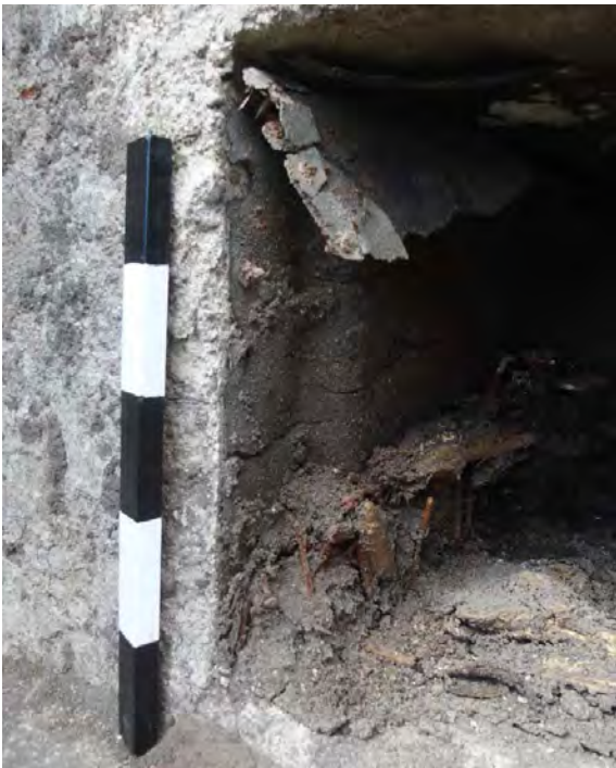
Kuva 15. Yksityiskohtakuva. Ampumatarvikekomeron seinillä erottuu ruuveja, joilla komeron sisällä ollut tervapahvi on kiinnitetty.
