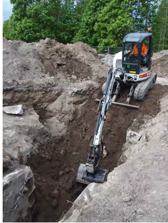
Kuva 3. Tutkimusalueen eteläpään laajennusosan koneellinen kaivuu kävi hankalaksi suurten korkeuserojen takia.
