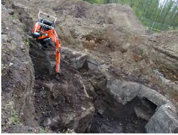
Kuva 2. Rakenteiden koneellinen kaivuu onnistui hyvin pienellä kaivinkoneella.
