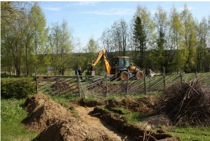
Kuva 5. Koeojien kaivutyöt tehtiin traktorikaivurin avulla, kuvattu lounaasta. AKDG 4280:9
