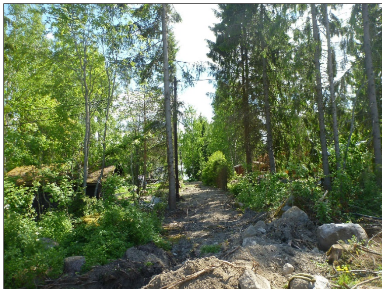
Luoteis- kaakko – suuntainen maakaapelikaivanto. Kaivettu ennen arkeologien saapumista paikalle. Kuvattu kaakkoon.
