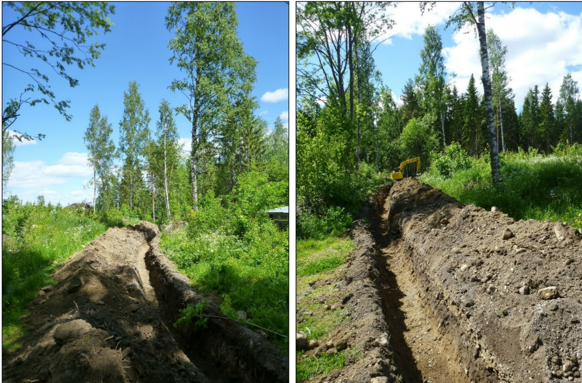
Määräsyvyyteen kaivettua kaivantoa kaakkoon ja lounaaseen.
