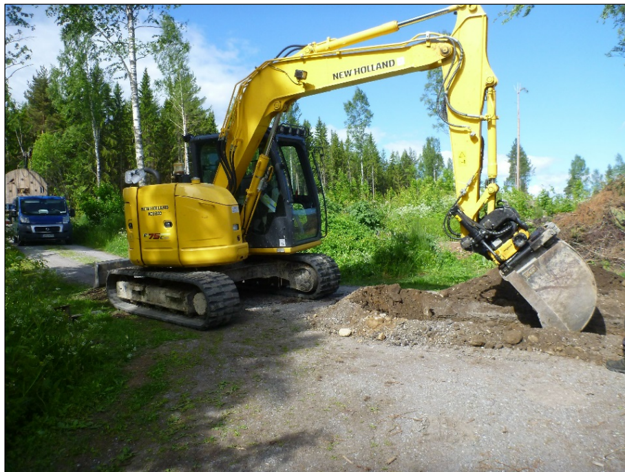
Kaapelikaivannon koneellista kaivamista hiekkapäälysteisen mökkien kaakkoisreunalla. Kuvattu lounaaseen.
