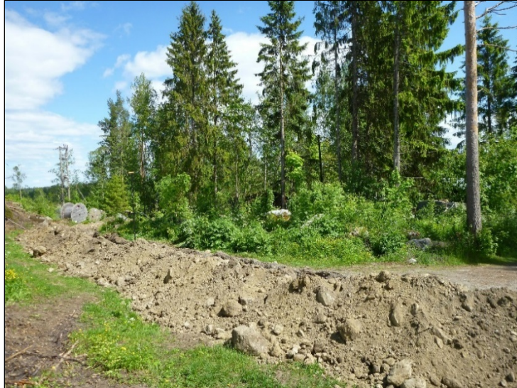
Tielinjalle kaivettua kaivantoa kuvattuna itään.
