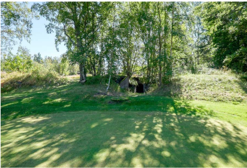
AKDG 4500:122. Maanalainen käytävän sisäänkäynti on nykyisin golf-kentän laidassa. Kuva koillisesta. Kuvaaja: V. Laulumaa.
