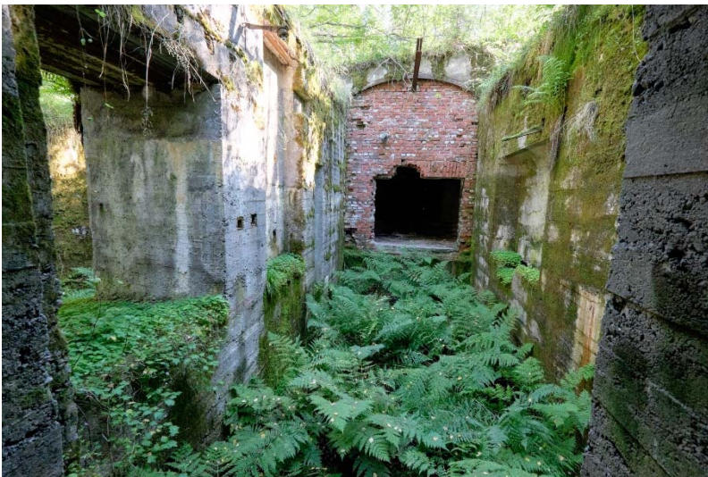
AKDG 4500:8. Isosaari 1. Keskussähköaseman idän puoleinen huone. Kuva pohjoisesta. Kuvaaja: V. Laulumaa.
