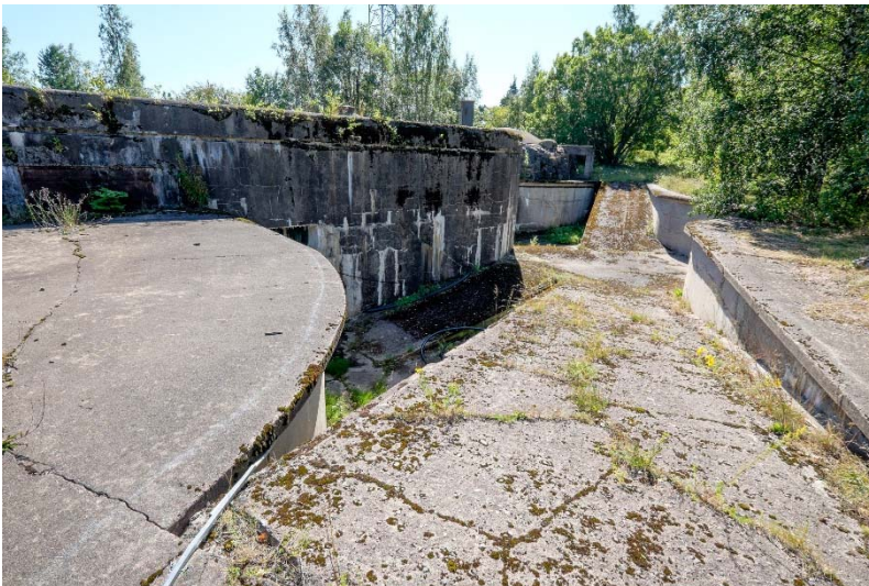
AKDG 4500:117. Tykkipatterin C länsiosan ajoramppeja. Kuva idästä. Kuvaaja: V. Laulumaa.
