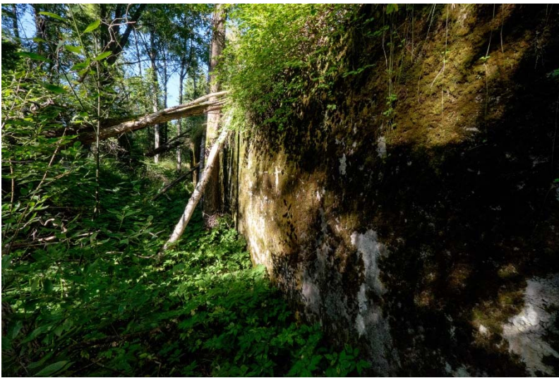
AKDG 4500:5. Isosaari 1. Keskussähköaseman länsiseinä. Kuva etelästä. Kuvaaja: V. Laulumaa.
