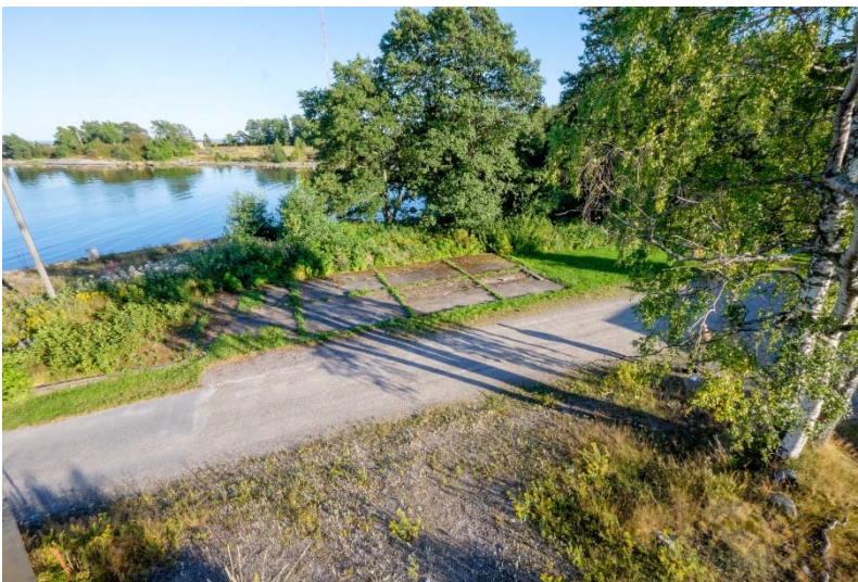
AKDG 4500:59. Isosaari 27. Veturitalin pohjan betonilaatat tien vieressä. Kuva luoteesta. Kuvaaja: V. Laulumaa.
