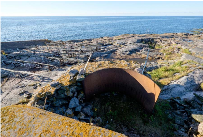
AKDG 4500:28. Isosaari 6. Etäisyysmittaustornin eteläpuolelle on rakennettu kivimuurilla ja suoja panssarilla varustettu tuli/tähystysasema. Kuva pohjoisesta. Kuvaaja: V. Laulumaa.
