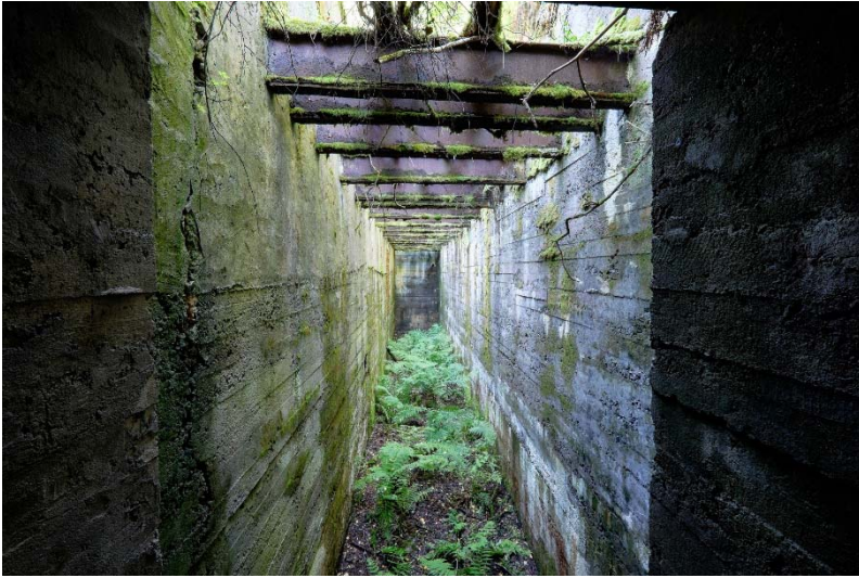
AKDG 4500:10. Isosaari 1. Keskussähköaseman lännen puoleinen huone. Kuva pohjoisesta. Kuvaaja: V. Laulumaa.
