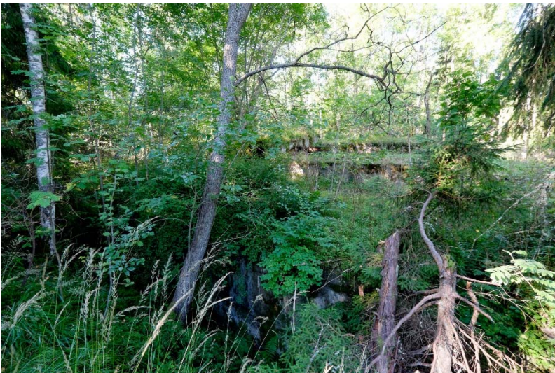
AKDG 4500:12. Isosaari 1. Keskussähköasema on metsittyntä lähes näkymättömiin. Kuva idästä. Kuvaaja: V. Laulumaa.
