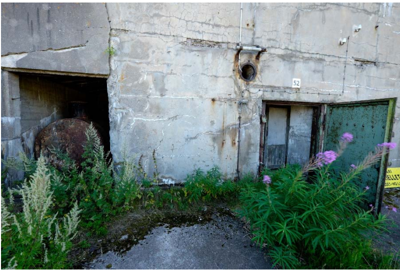
AKDG 4500:20. Isosaari 5. Valonheittinaseman sisäänkäynti ja polttoainesäiliön suoja. Kuva luoteesta. Kuvaaja: V. Laulumaa.
