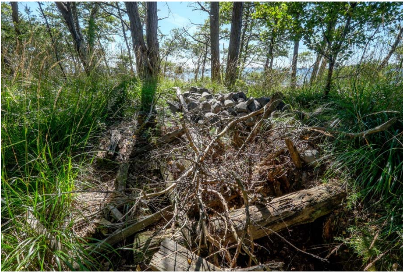
AKDG 4500:52. Isosaari 19. Ampumasema, jonka rannanpuolella kivivallia ja sisällä sortunut puurakenne. Kuva koillisesta. Kuvaaja: V. Laulumaa.
