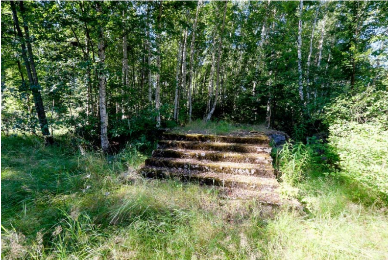
AKDG 4500:39. Isosaari 13. Portaat kasarmirakennuksen itäpäässä. Kuva idästä. Kuvaaja: V. Laulumaa.
