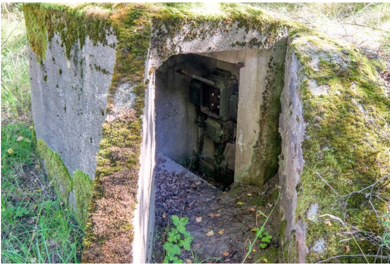
AKDG 4500:119. Tykkipatteri C. Muuntoaseman? suojakasematti sisältä. Kuvaaja: V. Laulumaa.
