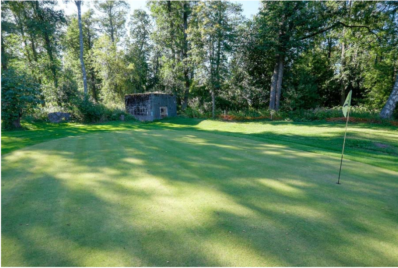
AKDG 4500:15. Isosaari 3. Kaapelikasematti golfkentän laidalla. Kuva idästä. Kuvaaja: V. Laulumaa.
