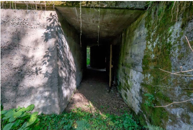
AKDG 4500:6. Isosaari 1. Keskussähköaseman sisääntulo. Kuva länneestä. Kuvaaja: V. Laulumaa.
