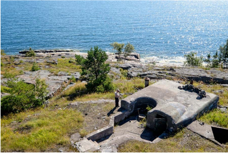
AKDG 4500:69. Isosaari 32. Betoninen varastorakennus ja ampuma-asema. Kuva pohjoisesta. Kuvaaja: V. Laulumaa.
