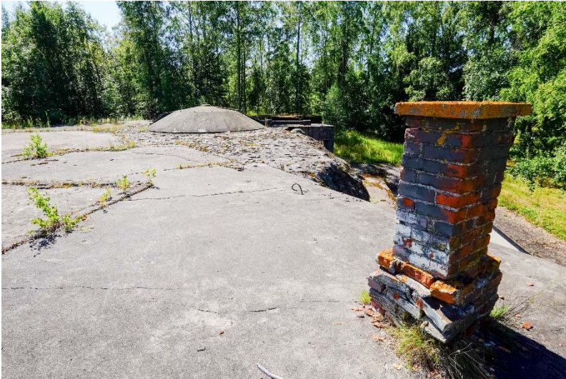
AKDG 4500:106. Tykkipatterin B länsiosaa. Kuva idästä. Kuvaaja: V. Laulumaa.
