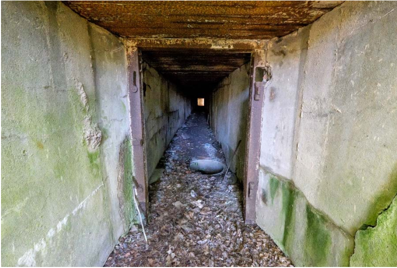
AKDG 4500:121. Tykkipatterin ja päätien välinen käytävä kuvattuna päätien suunnasta. Kuvaaja: V. Laulumaa.
