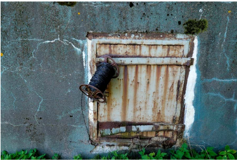
AKDG 4500:16. Isosaari 3. Kaapelikasematin ovi. Kuvaaja: V. Laulumaa.
