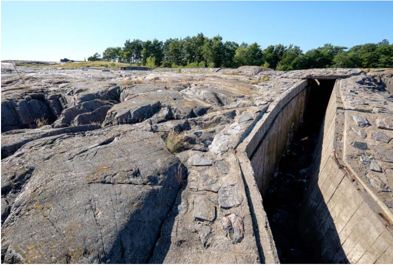
AKDG 4500:86. Isosaari 37. Kallioon louhittuja ja osin katettuja taisteluhautoja niemen koillisestä. Kuvaaja: V. Laulumaa.
