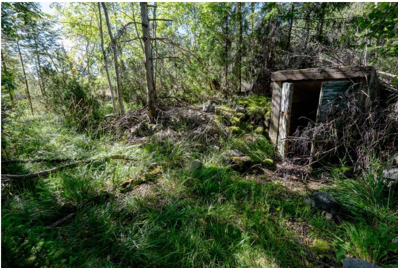
AKDG 4500:80. Isosaari 35. Betoniseinäinen rakennus, jonka käyttötarkoitus ei ole selvä, mahdollisesti tähystys- tai mittausasema. Kuva pohjoisesta. Kuvaaja: V. Laulumaa.
