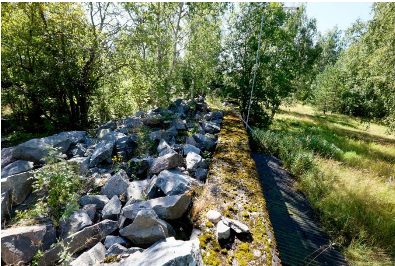
AKDG 4500:111. Tykkipatterit yhdistävää betonimuuria. Kuva idästä. Kuvaaja: V. Laulumaa.
