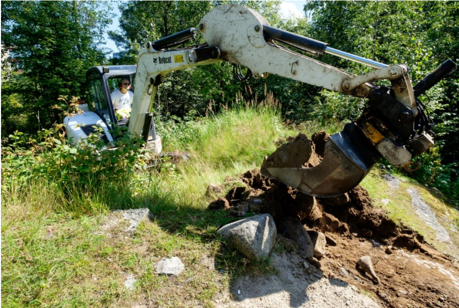
AKDG 4269:12. Koejaa 5 kaivetaan koneella. Kuva pohjoisesta. Kuvaaja: Vesa Laulumaa/ARKE.
