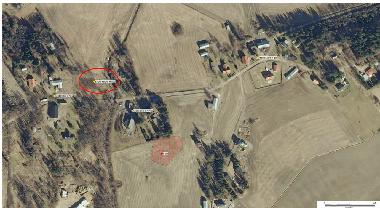
Flyfoto av objektet
