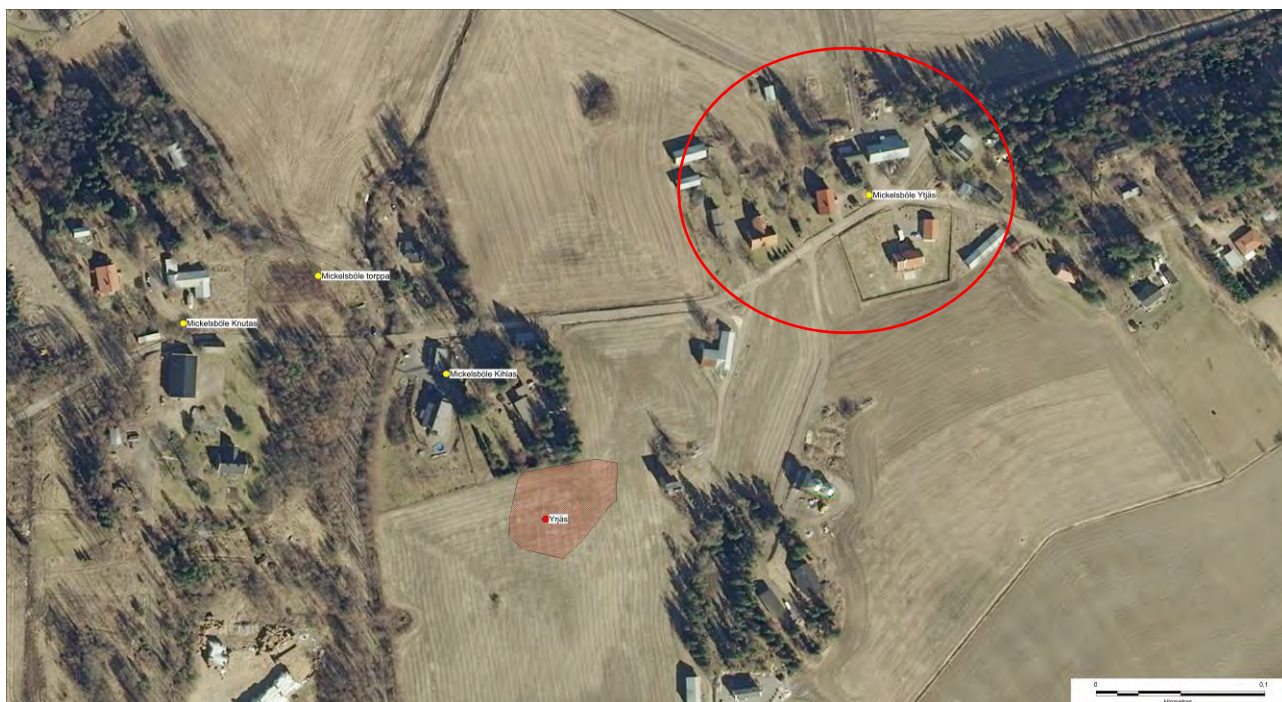
Flyfoto av objektet
