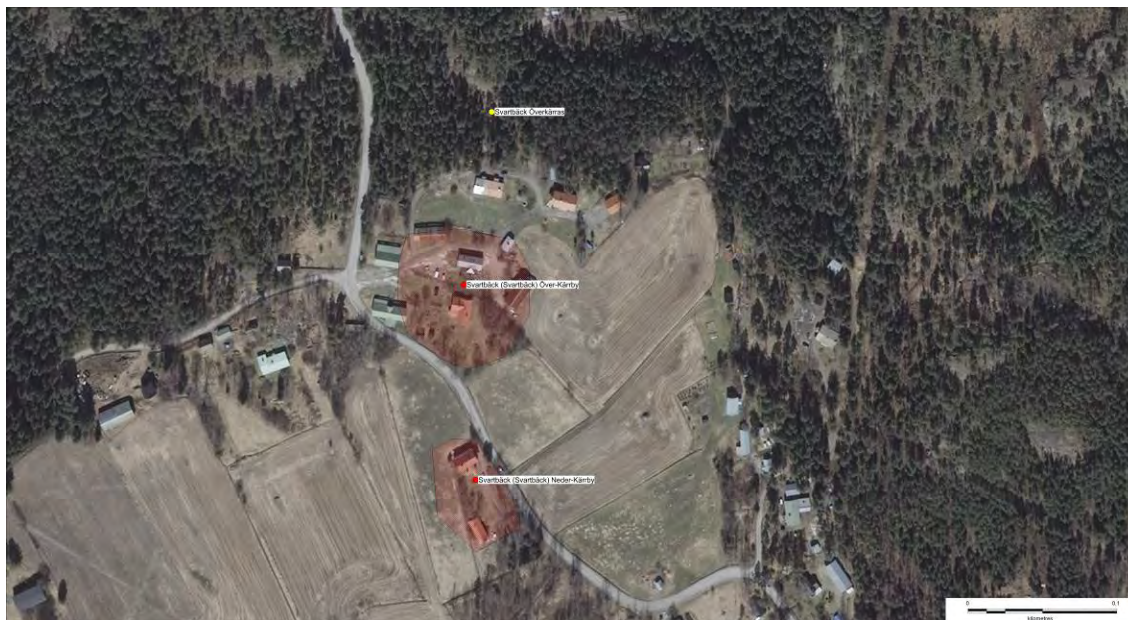
Flyfoto av objektet
