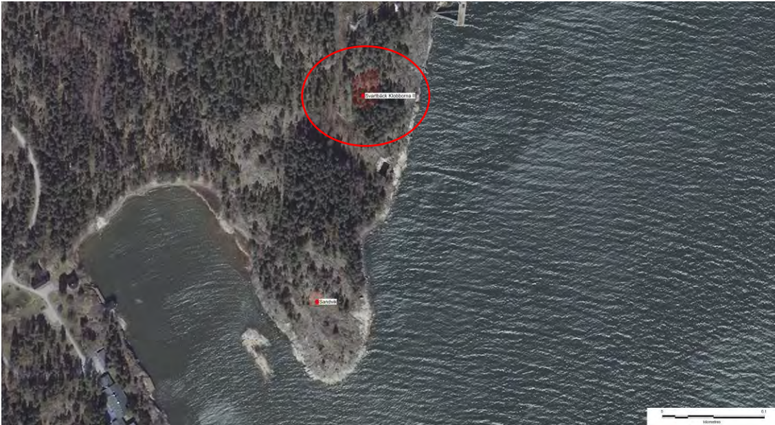
Flyfoto av objektet
