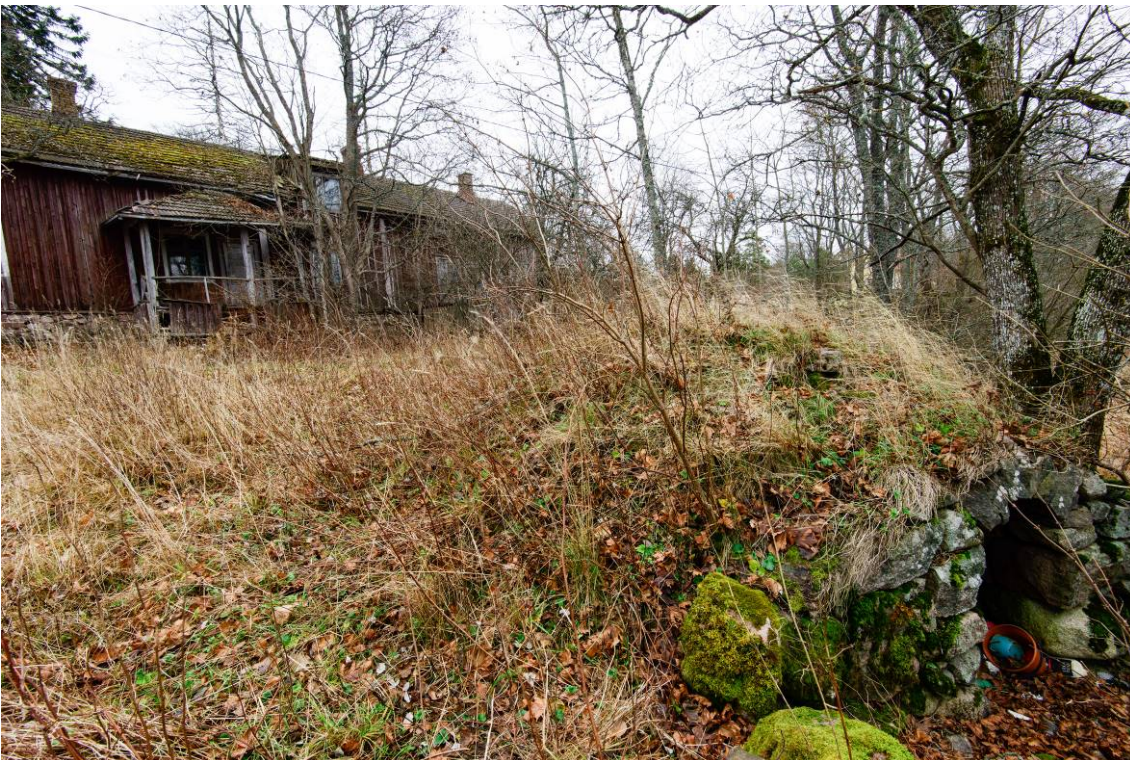
Kuva 18. Nedre Jussilan talo ja kellari kuvan oikeassa alakulmassa. Kuva lounaasta. (AKDG4602:18)
