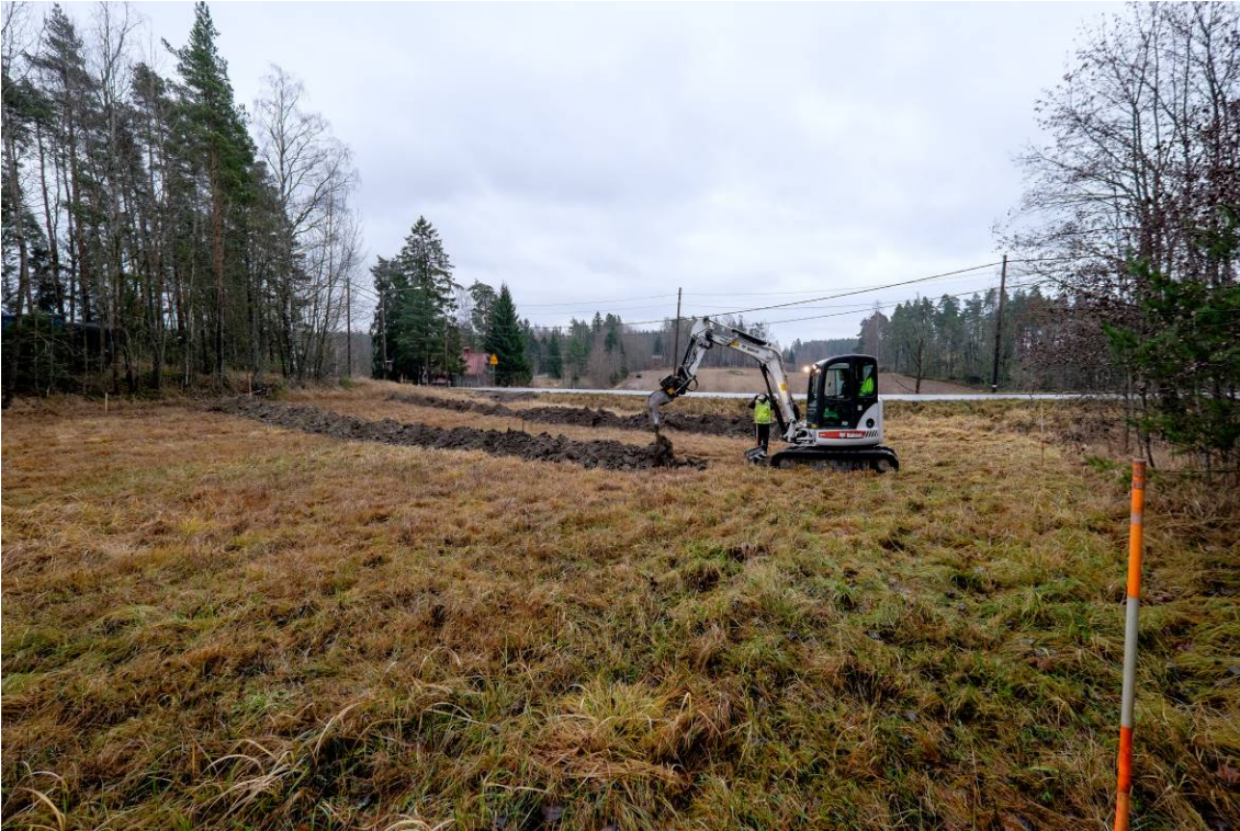
Koeojia kaivetaan tutkimusalueen etelä osassa. Kuva luoteesta. (AKDG4601:3)
