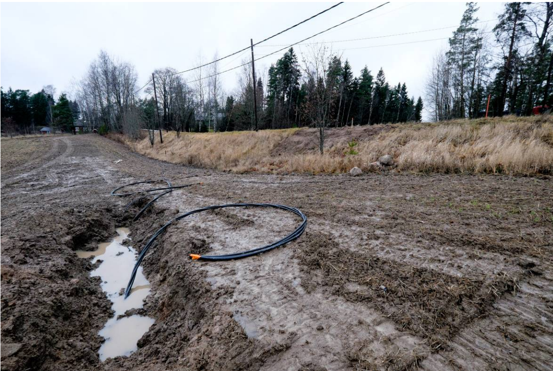
Lapinjärventien eteläpuolella olevaa peltoa, jolle on vedetty kaapeli syksyllä 2015. Kuva idästä. (AKDG4601:4)
