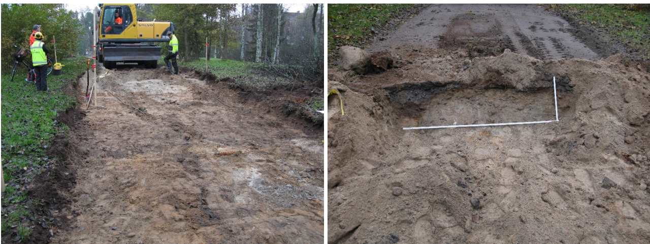
Pohjamaata ja kerrosta SY5. Profiilikuvassa erottuu hyvin L3 kaapelikaivanto ja pinnoituskerroksen SY1 ohuus. AKDG4493:7 ja 9.
