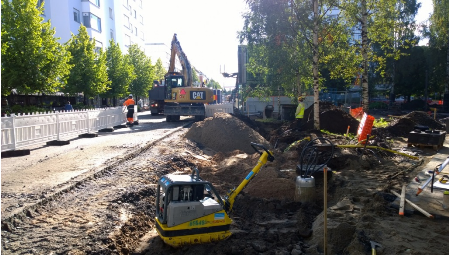
AKDG 4274_33. Kaivua Hallituskadun reunalla. Kaakkoon. Kuvaaja: Petro Pesonen.
