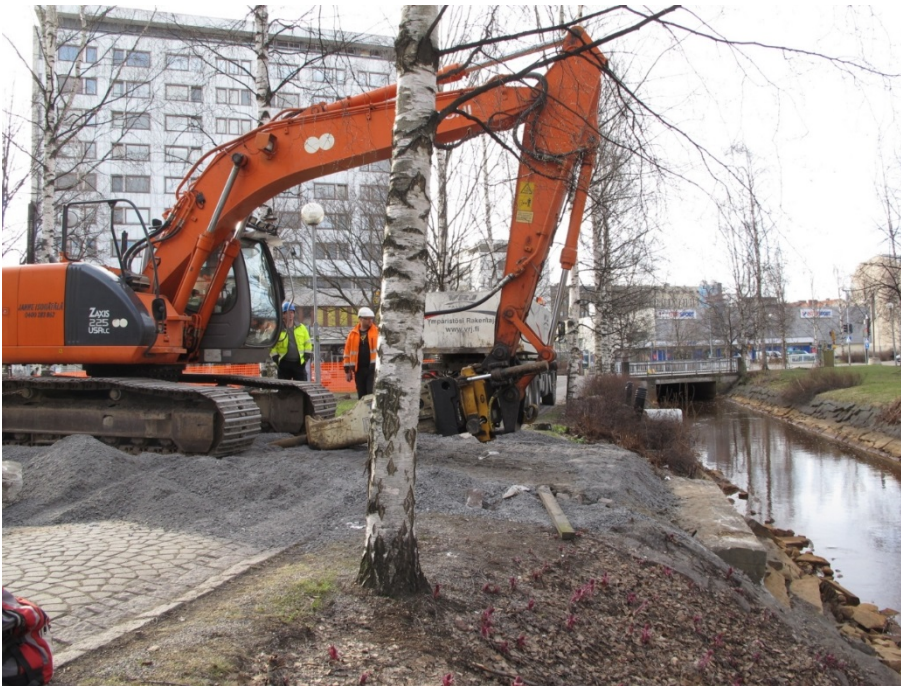
AKDG 4274:1. Otto Karhin puiston työmaa - aloituskuva. Kuvaaja: Terhi Taipaleenmäki.
