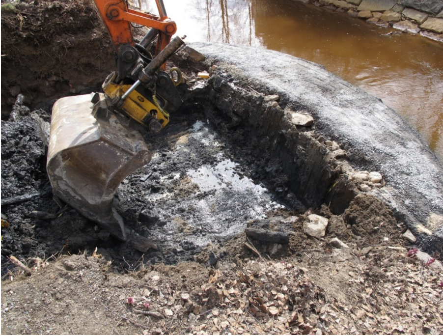
AKDG 4274_7. Työkuva - betoni kivien alla. Etelään. Kuvaaja: Terhi Tanska.
