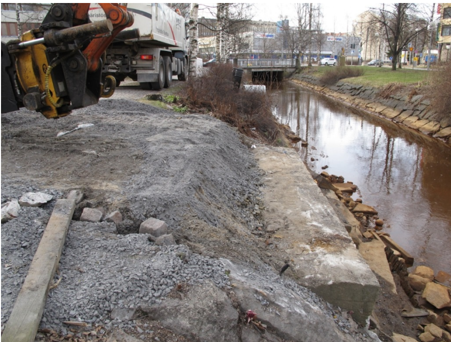
AKDG 4274_2. Lähikuva betonianturasta. Kaakkoon. Kuvaaja: Terhi Taipaleenmäki.
