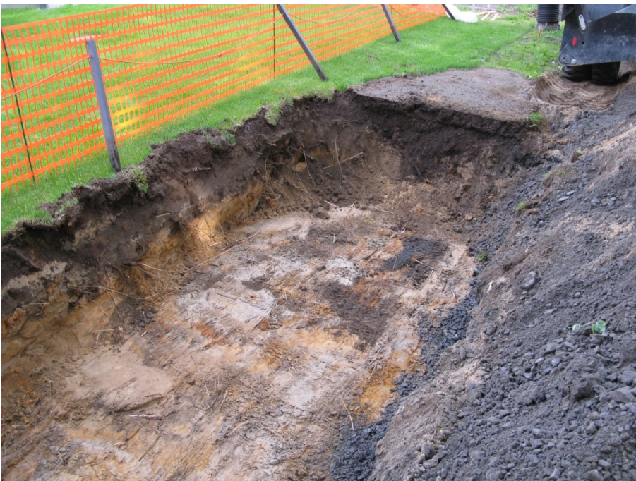
AKDG 4274_22. Toisen penkin alusta, yleiskuva kaivannosta, pohjamaa näkyvissä. Luoteeseen. Kuvaaja: Terhi Tanska.
