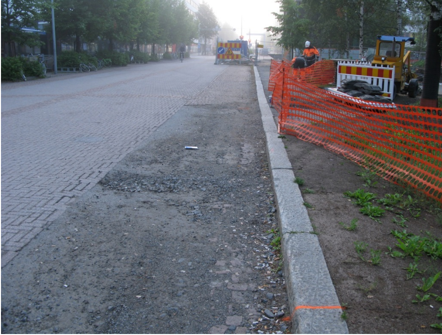
AKDG 4274_31. Avattava alue ennen aloitusta. Kaakkoon. Kuvaaja: Terhi Taipaleenmäki.
