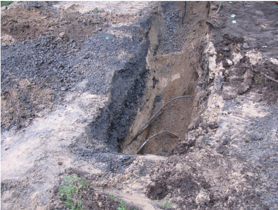
AKDG 4274_16. Ensimmäisen valopylvään kaivanto. Pohjoiseen. Kuvaaja: Terhi Tanska.
