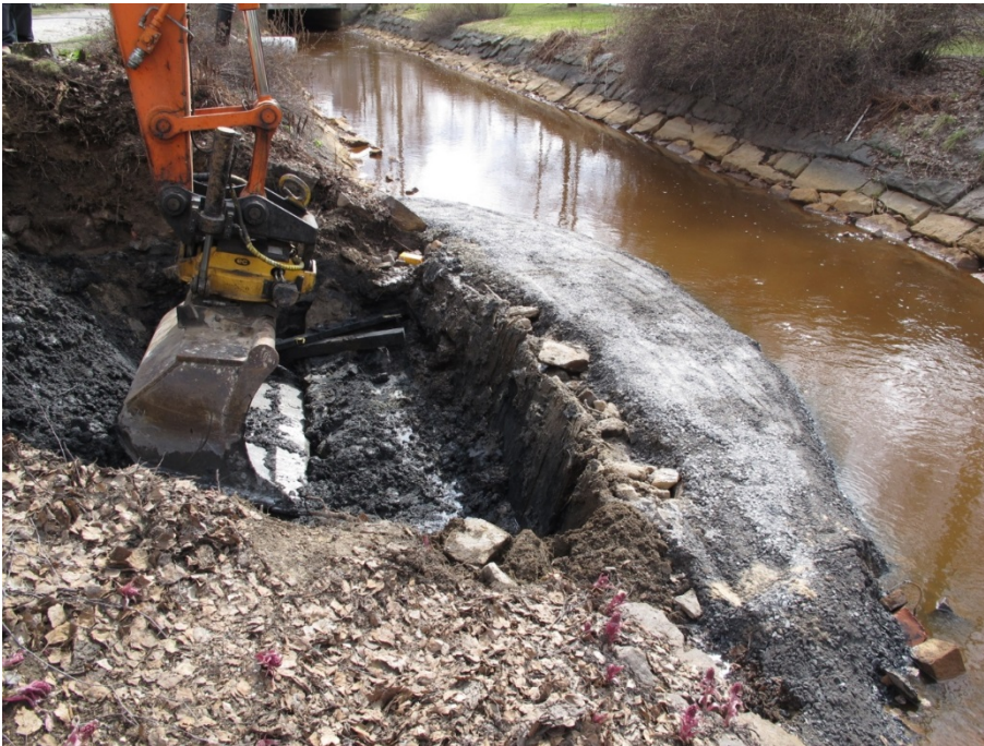
AKDG 4274_8. Työkuva - betonin loput ja se mitä sen alla oli. Etelään. Ku- vaaja: Terhi Taipaleen- mäki.
