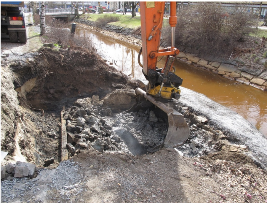
AKDG 4274_6. Työkuva - kivien poisto. Etelään. Ku- vaaja: Terhi Taipaleen- mäki.
