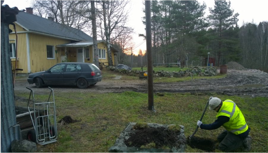
AKDG 4609:20. Koekuoppaa 19 kaivetaan. Kuva pohjoisesta. Kuvaaja: Petro Pesonen.
