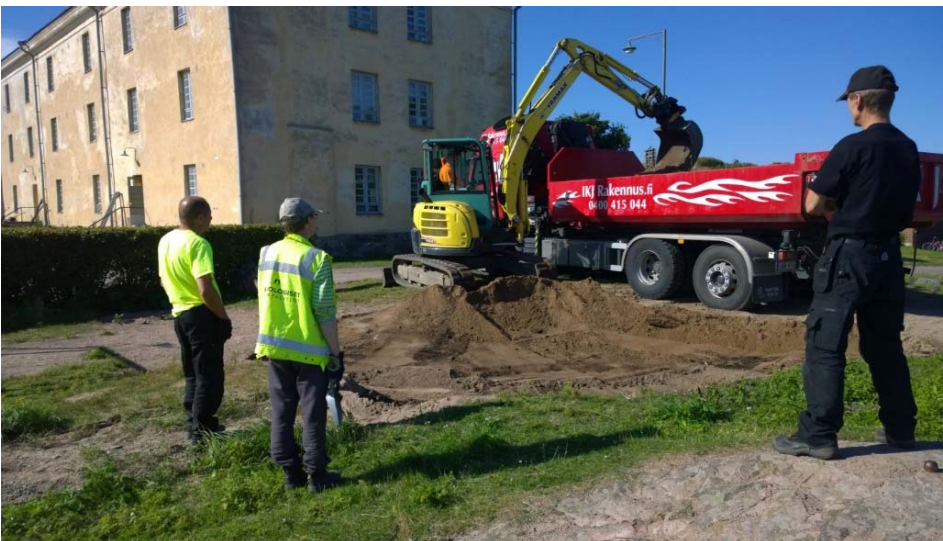
AKDG 4606:5. Leikkilaitilan paikan kaivua, luoteeseen. Kuvaaja: Petro Pesonen.
