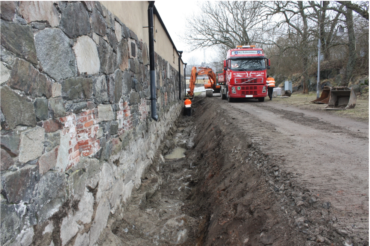
AKDG 4604:15. Yleiskuva itäisestä kaivannosta kohti länttä. Kuvaaja: Johanna Seppä.
