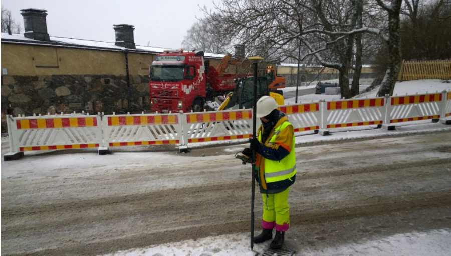
AKDG 4604:5. Johanna Seppä tekee mittauksia VRS-GPS-laitteella, lounaaseen. Kuvaaja: Petro Pesonen.
