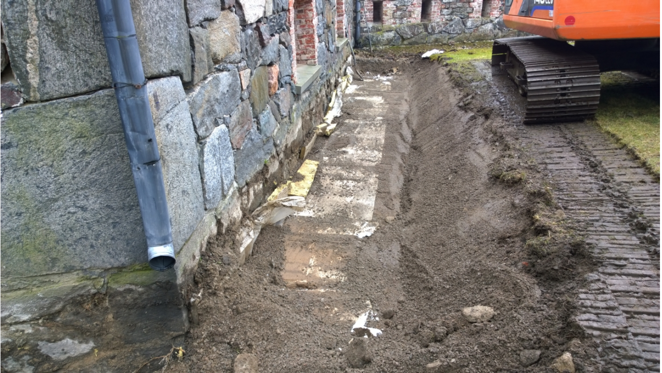
AKDG 4604:9. Kaivanto styroksieristeisiin saakka kaivettuna, itäisen kaivannon lyhyt koillinen-lounassuuntainen osa, etelään. Kuvaaja: Petro Pesonen.
