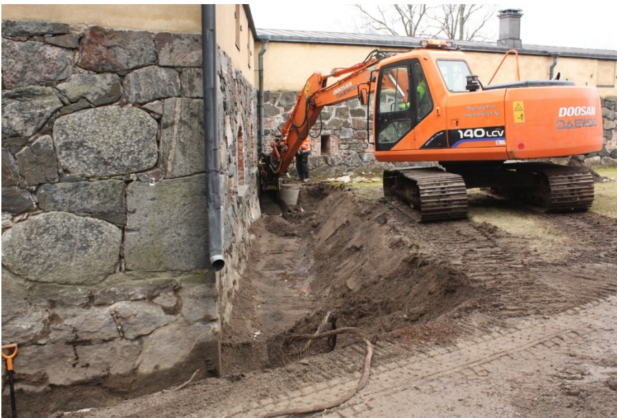
AKDG 4604:19. Itäisen kaivannon lyhyttä seinäosuutta aletaan kaivamaan, lounaaseen. Kuvaaja: Johanna Seppä.
