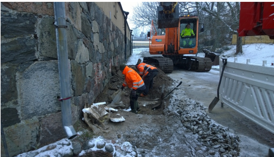
AKDG 4604:4. Kiveyksen poistoa rakennuksen C31 edustalta, länteen. Kuvaaja: Petro Pesonen.
