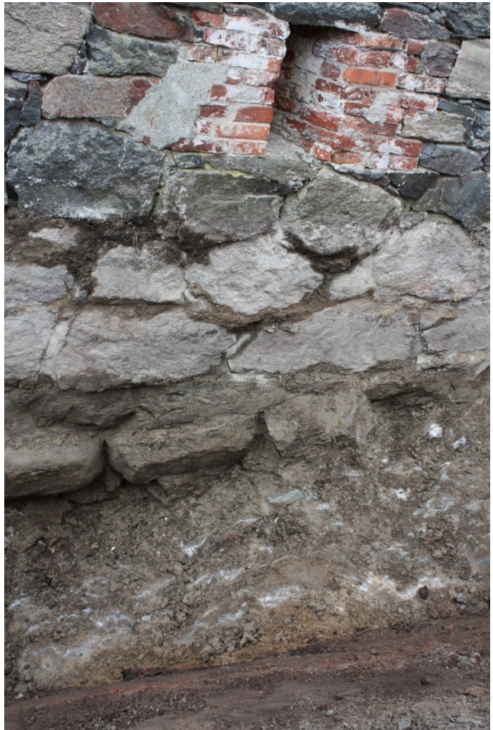
AKDG 4604:14. Rakennus C31 on perustettu kalliolle, kuva seinän perustuksista itäisen kaivannon kohdalla. Kuvaaaja: Johanna Seppä.
