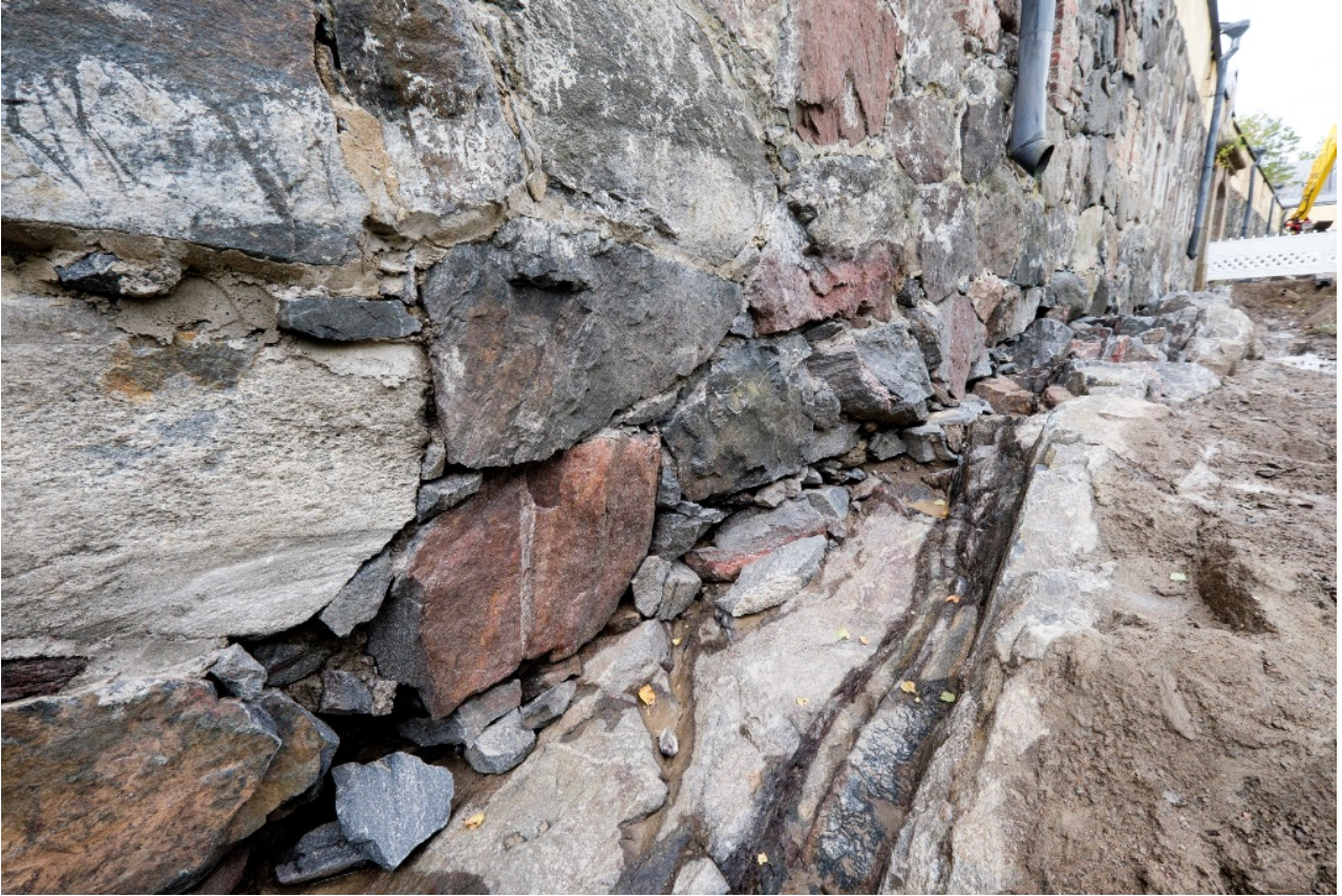
AKDG 4604:37. Kallio ja seinä pestynä portin itäpuolella ennen uusien eristemateriaalien asentamista. Kuva idästä. Kuvaaja: Vesa Laulumaa.
