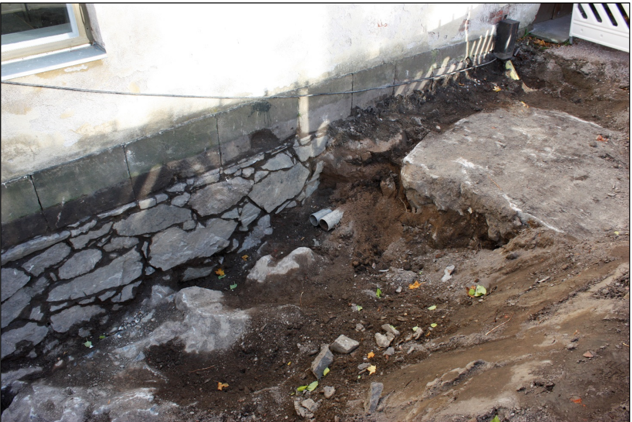
Kuva 10. Työmaakaivanto päättyi itäpäässään betonilaattaan. Kuvattu lännestä. AKDG4598:11.
