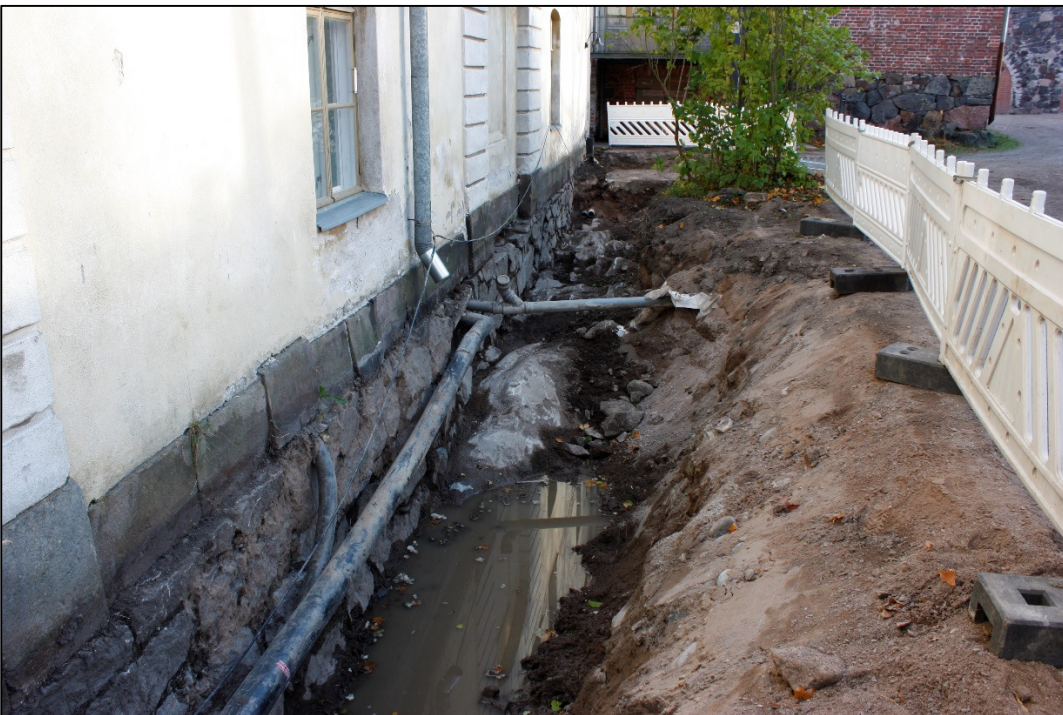
Kuva 8 Pihan itäosan työmaakaivanto. Kuvattu luoteesta. AKDG4598:10.
