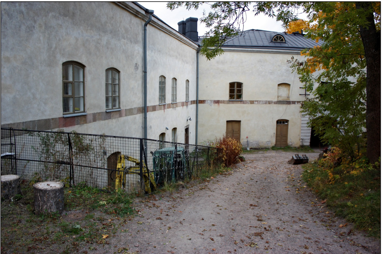
Kuva 2. Puolibastioni Hjärnen edessä piha-alue laskeutuu jyrkästi alaspäin. Tukimuuri ja sen päälle pengerretty tie ovat peräisin 1800-luvun loppupuolelta. Kuvattu lännestä. AKDG4598:1.
