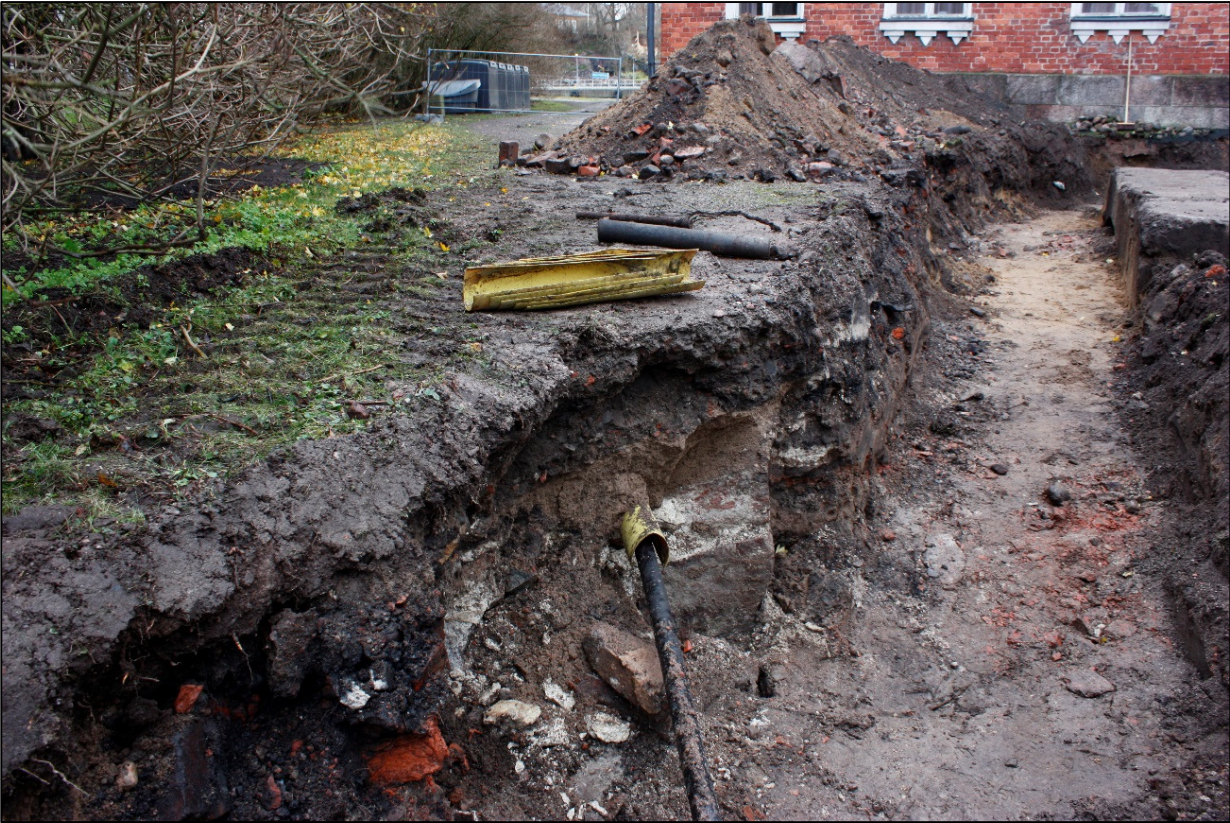
Kuva 6. Sähkökaapelin alapuolella on muurattu kiviperustus, joka saattaa olla 1840-luvulla suunnitellun sairaalarakennuksen perustuksen kulma. Taustalla oikealla saunan pannuhuoneen perustus. Kuvattu luoteesta. AKDG4600:3.
