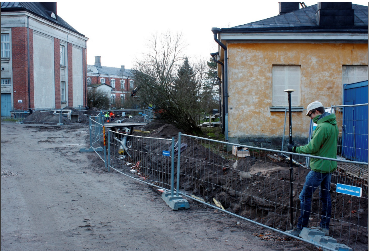
Kuva 4. Niko Anttiroiko kartoittaa työmaakaivantoa VRS-GPS-paikantimella. AKDG 4600:11.
