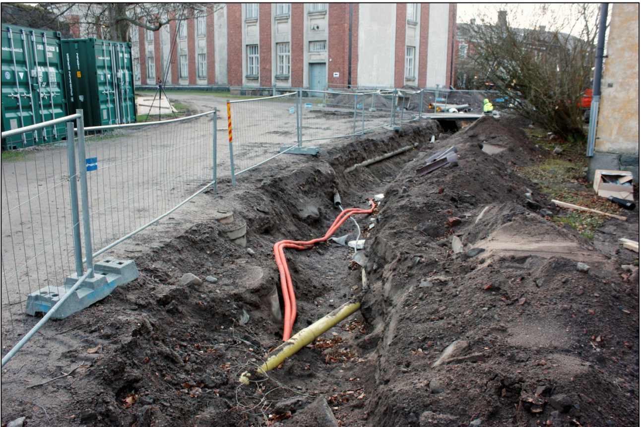
Kuva 5. Työmaan kaivannossa oli runsaasti jo aikaisemmin asennettua kunnallistekniikkaa. Kuvattu luoteesta. AKDG4600:12.
