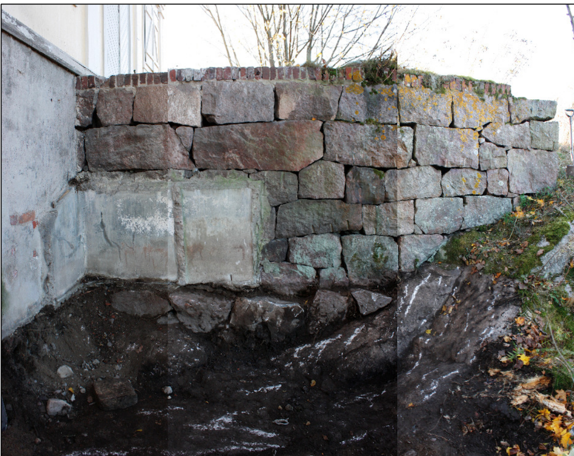
Kuva 7. Kuvakooste kahvilarakennuksen pohjoisnurkalta, josta on purettu pois vanhat käymälätilat. Kuvattu koillisesta. AKDG4599:5.
