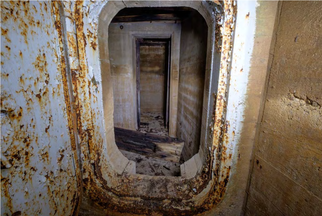
Kuva 7. Näkymä oviaukolta sulkuhuoneeseen. (AKDG4603:7)
