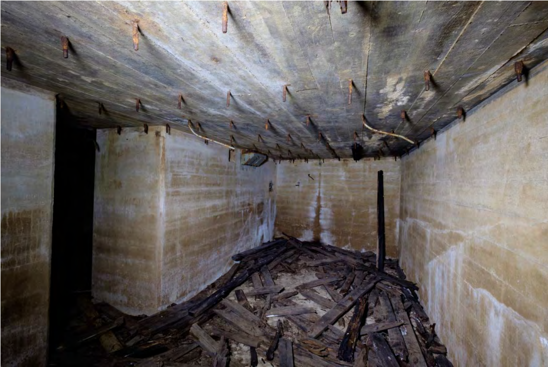
Kuva 11. Perimmäinen huone. (AKDG4603:11)
