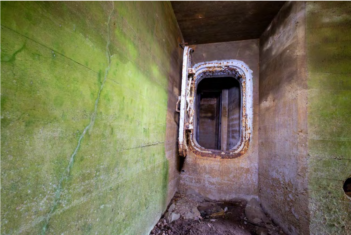
Kuva 6. Korsun sisäänkäynnin teräsovi. (AKDG4603:6)
