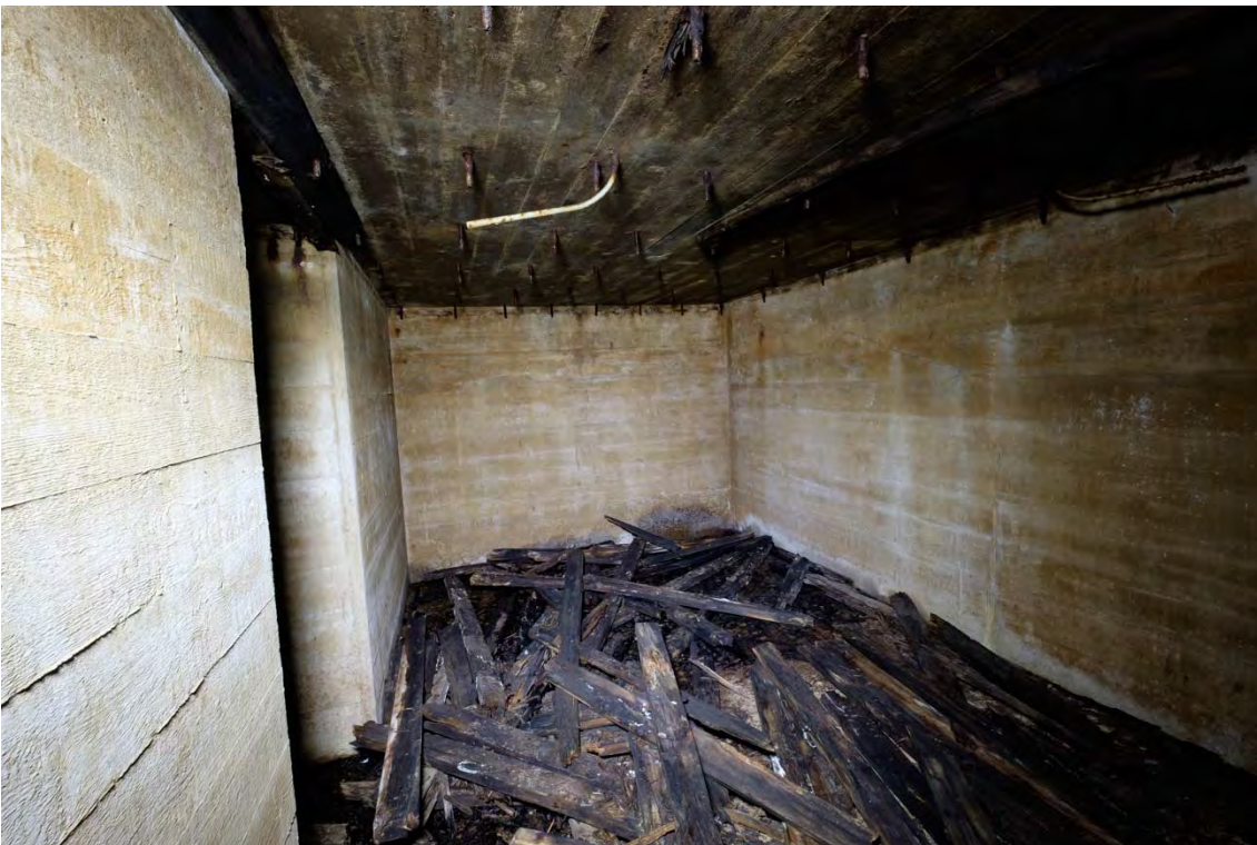
Kuva 8. Ensimmäinen huonetila sisään tullessa. Katon lautaverhoilu on lahonnut ja pudonnut lattialle. (AKDG4603:8)
