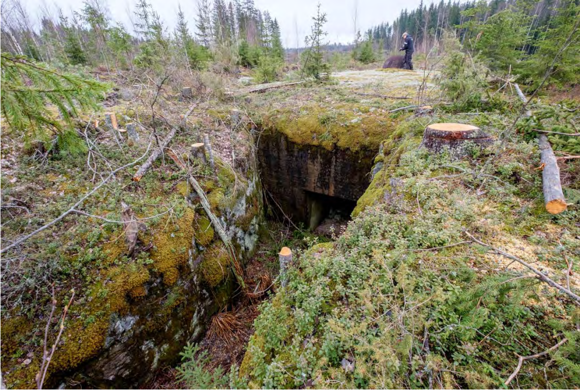
Kuva 3. Korsun 67 sisäänkäynti ylhäältä. (AKDG4603:3)
