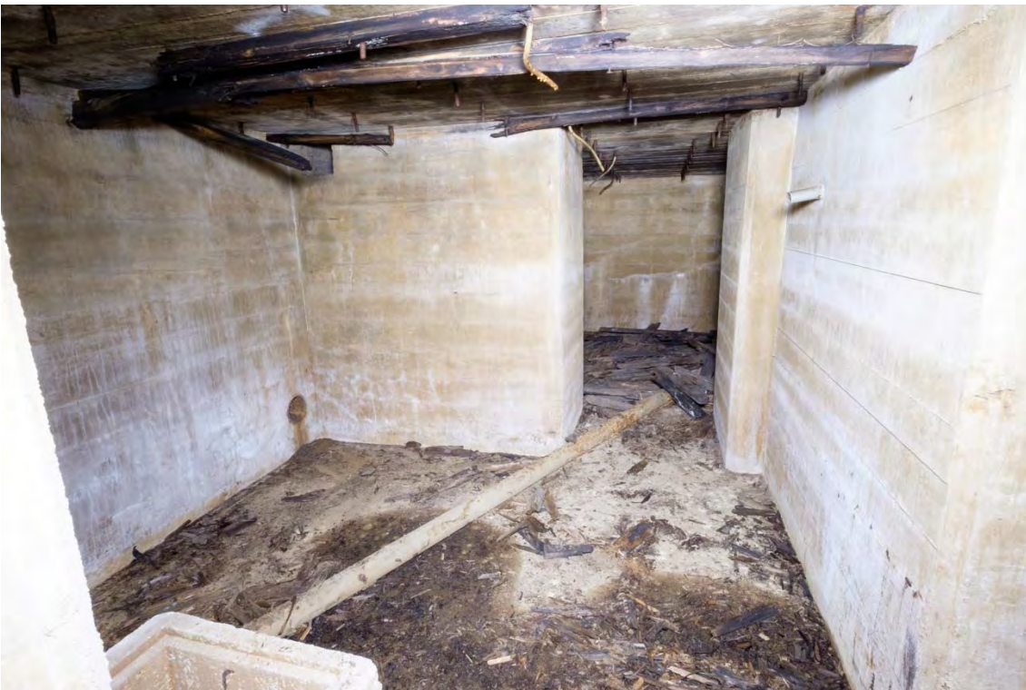
Kuva 23. Viemärintiputki lattialla kulkee perähuoneesta keittiöön, vasemmassa nurkassa vesisäiliö. (AKDG4603:23)
