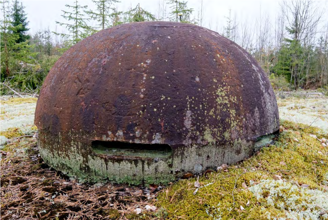
Kuva 5. Korsun 67 tähystyskupu. (AKDG4603:5)
