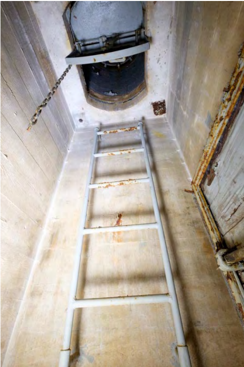
Kuva 17. Kupukammiossa, tähystyskupuun johtavat tikkaat. (AKDG4603:17)
