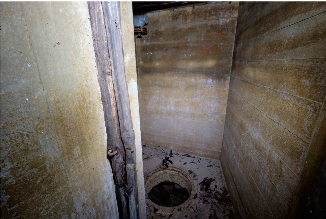
Kuva 15. Kokoajakaivo sulkuhuoneen vieressä. Tässä huoneessa oli myös vessa. (AKDG4603:15)
