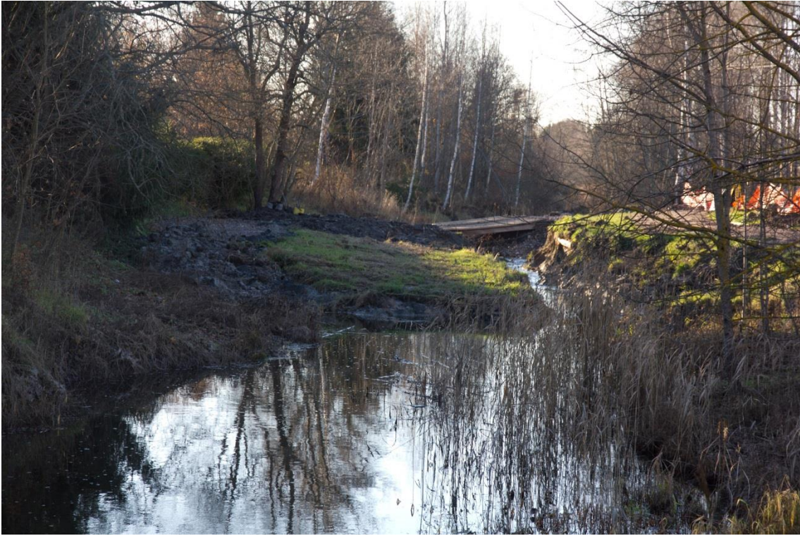
Kuva 2. Espoonjokeen romahtanut maa-aines on selkeästi erotettavissa etualan kaislikon ja taka-alan kulkusillan rajaamalla alueella (AKDG4524: 1).
