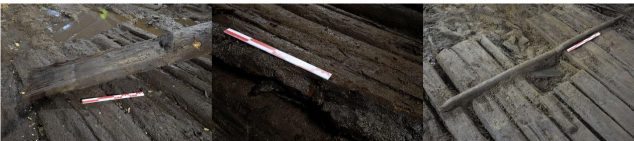
AKDG3910:245-247. Erilaisia loveuksia ja kavennuksia rakenteen R78 puissa. Oikeassa reunassa rakenteet R78B poikkipuu rakenteen R81 päällä. Kuvat Vesa Laulumaa, Arkeologiset kenttäpalvelut 11.12.2014
