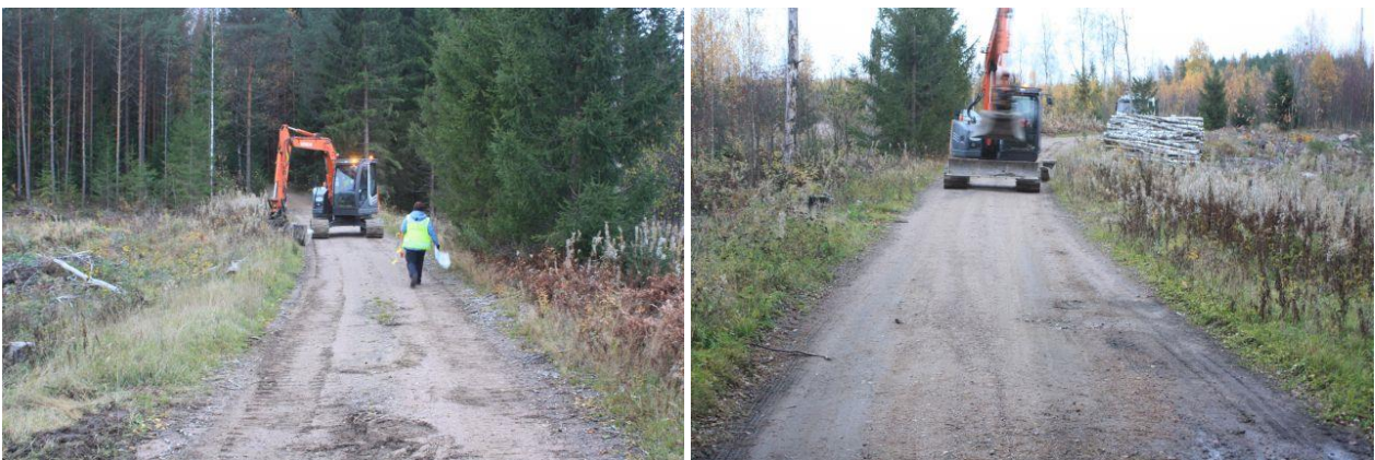
Vasemmalla AKDG3880:1 . Suuren Rantatien linjaa Uistesuon kohdalla idästä kuvattuna. Kuvassa kaivinkone ja Tuija Väisänen. Oikealla AKDG3880:4 Mestarmäentien eli Suuren Rantatien linjaa kohti itää. Tutkimusalue kuvan etualalla. Kuvat Esa Mikkola, Arkeologiset kenttäpalvelut 14.10.2014 (Huom! Kuvat otettu lokakuun esitutkimusten yhteydessä)
