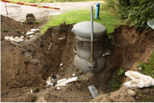
Kuva 14. Pumppaamo esille kaivettuna, kuvattu koillisesta. AKDG 4666:11
