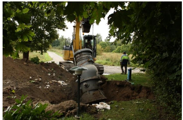
Kuva 11. Pumppaamon nosto, kuvattu koillisesta. AKDG 4666:12
