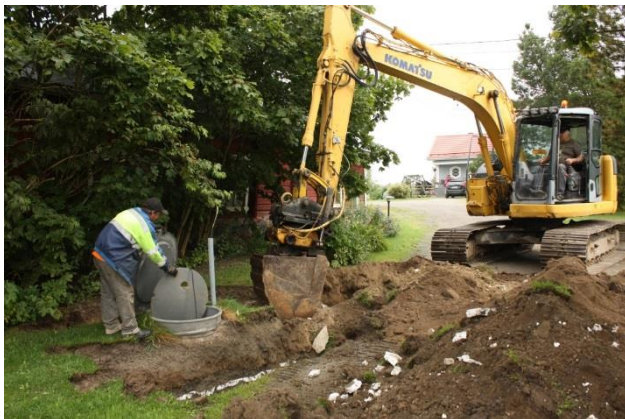
Kuva 10. Pumppaamon siirtoa varten tapahtuva kaivutyö, kuvattu etelästä. AKDG 4666:9
