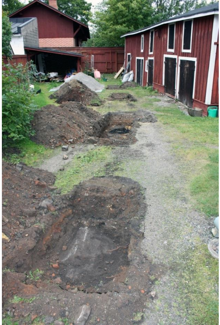
Kuva 5. Koeojat kaivettuna tulevan putkilinjan kohdalle, kuvattu kaakosta. AKDG 4671:3
