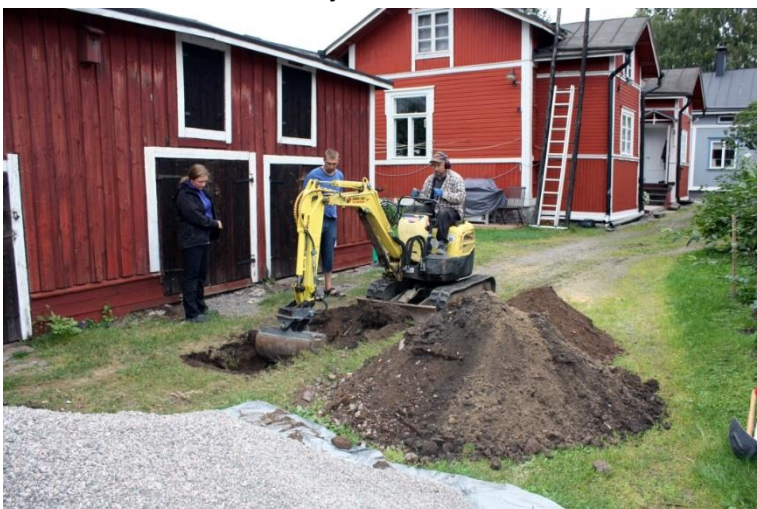
Kuva 4. Pintamaat poistetaan koeoja 2 kohdalta, kuvattu lännestä. AKDG 4671:16
