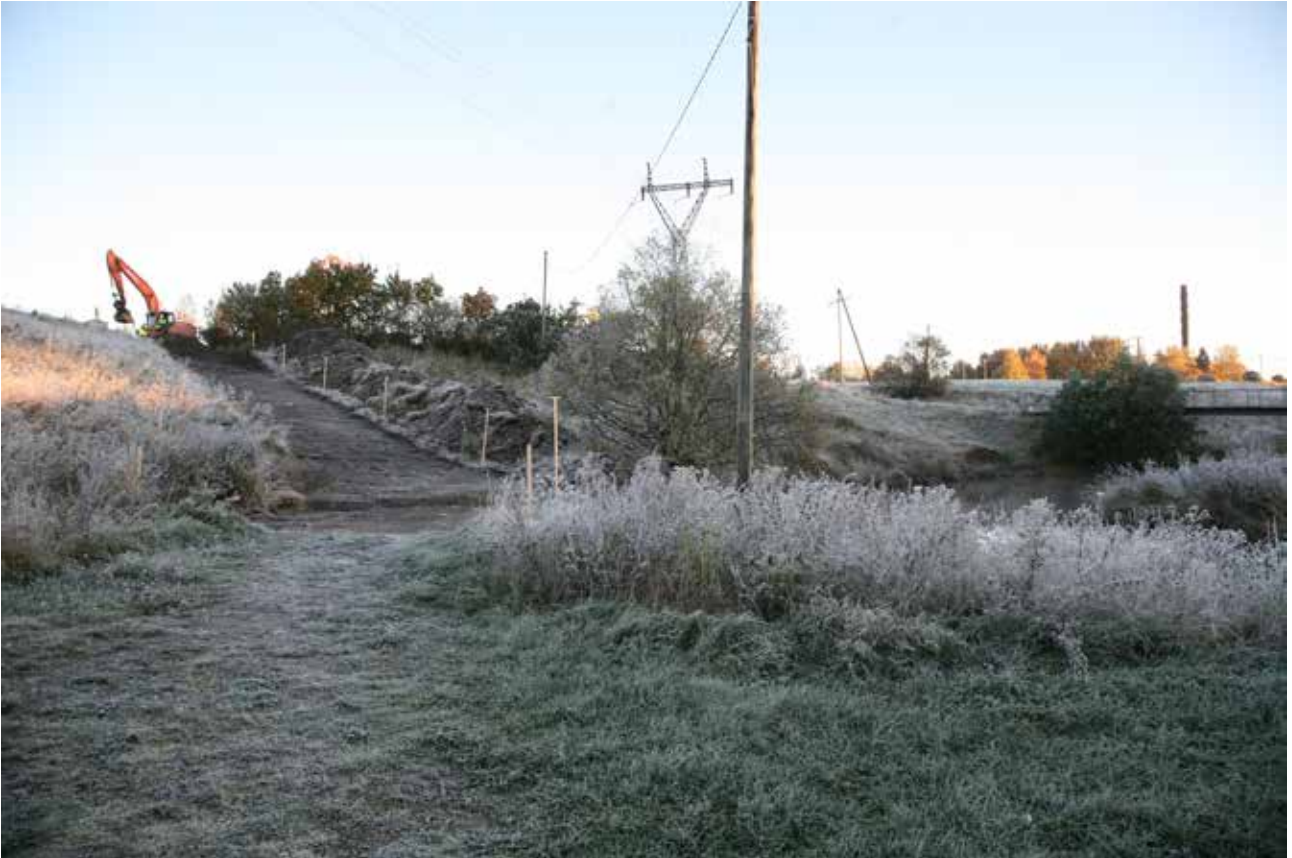
DT2015:47:3 IMG 3921 Tielinja alhaalta ylöspäin. Oikealla Vähäjoki ja Koroisiin vievä silta. S. 8.10.2015 MH.
