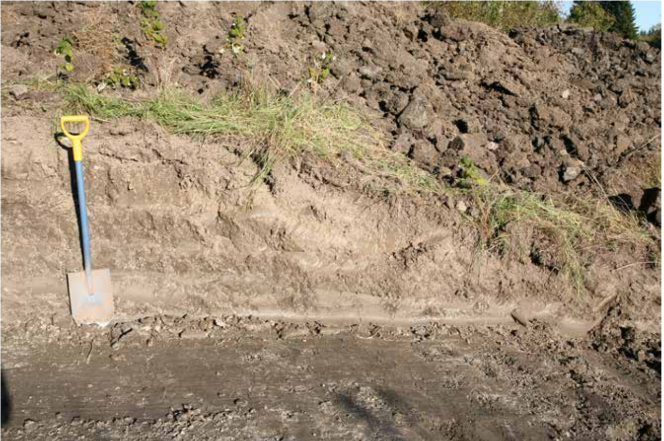
DT2015:47:1 IMG 3905 Kaivannon profilia rinteän yläosassa. SW 8.10.2015 MH.
