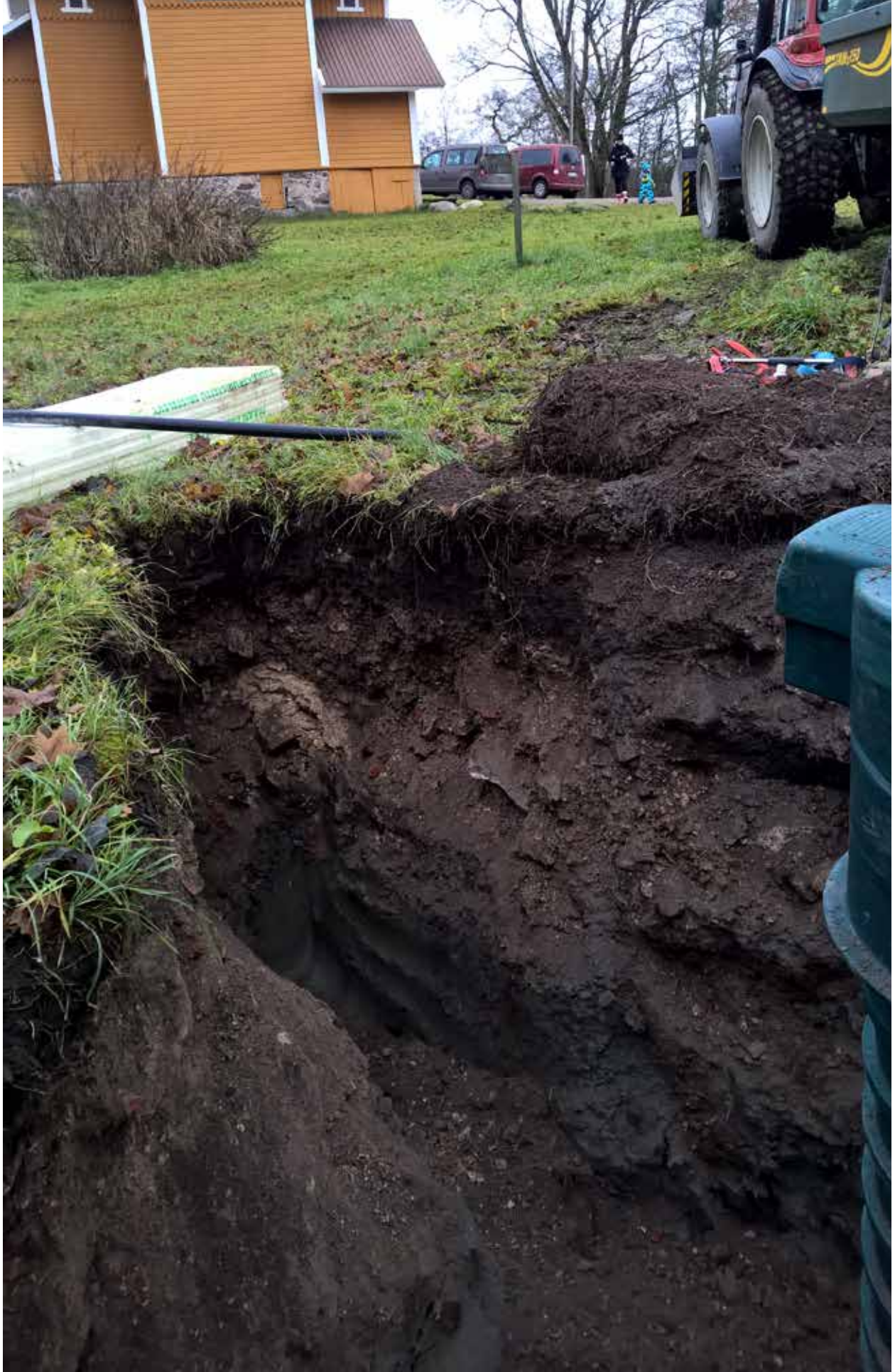
Kuva 1. Putkikaivannon jatko-osa kohti vartijanmökkii. Alueella on savikerroksen päällä paksu täytötkerros. NW. K.Uotila. Marraskuu 2015.
