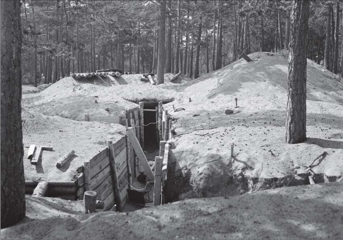
Kuva 5. Linnoitteiden tukimateriaaleina käytettiin mm. hirssiä ja lautoja. Kuva Plagenin uimarannalta 1942. Valokuva: E. Suomela, SA-kuva.
