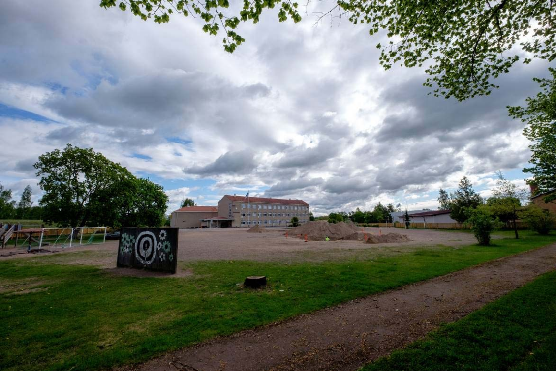
Kuva 9. Koulun pihamaa kaivausten käynnistyttyä. Kuva lounaasta. (AKDG4683:9)
