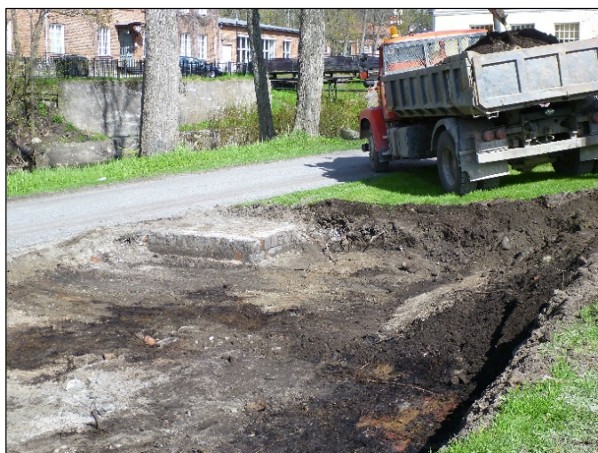
Kaivannon pohjoiskulma. Rakenne kaivannon kulmassa. Kuvattu pohjoiseen.
