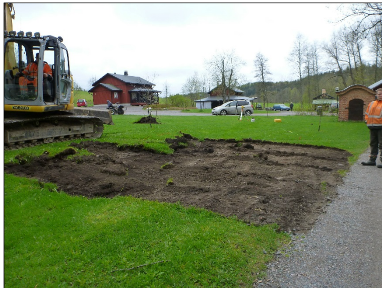
Pintamaiden poistoa kavettavalta alalta. Kuvattu etelään.
