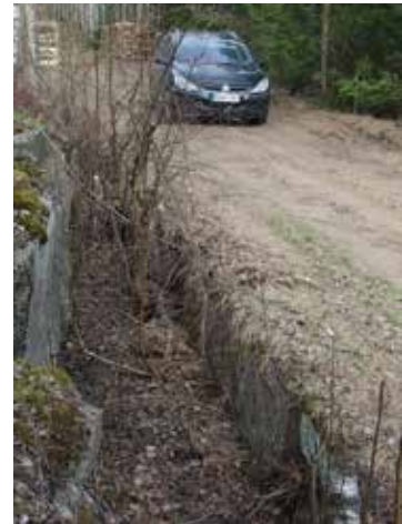
Entinen ratalinja on louhittu kallioon ja ratapohjan reunat on kivetty.
