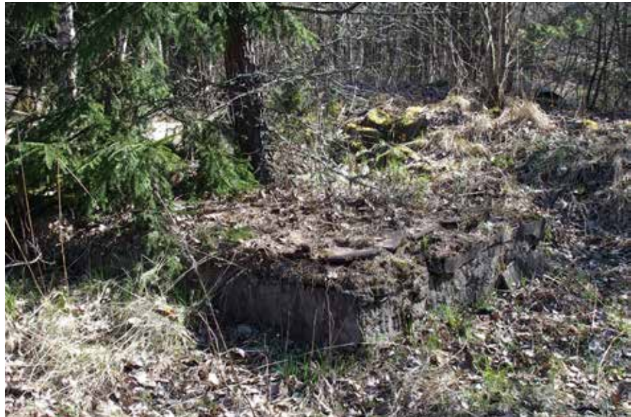
Siggans, rakenteet D, alakohde b. Betoniantura kuvattuna etelästä.
