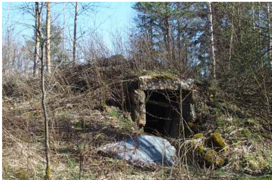
Siggans, rakenteet D, alakohde c. Maakellari kuvattuna lounaasta.
