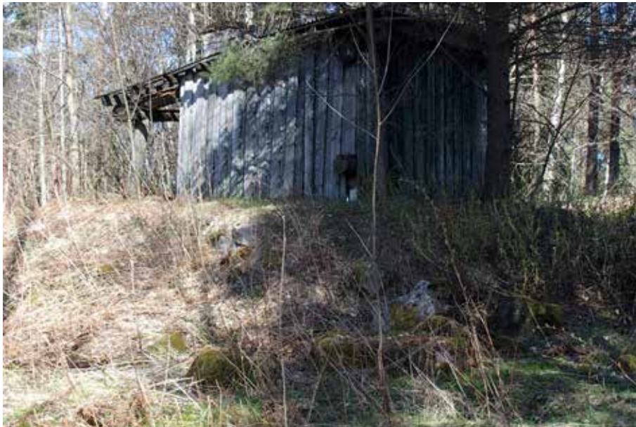
Siggans, rakenteet D, alakohde e. Grillikatoksen alla sijaitseva vanhempi perustus. Kuvattu etelästä.
