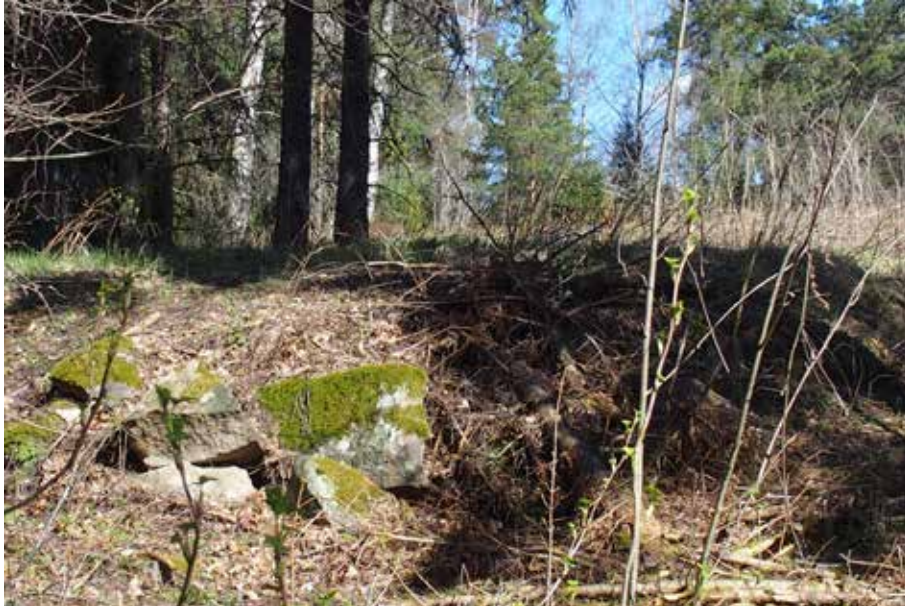
Siggans, rakenteet D, alakohde d. Rakennuksenperustus kuvattuna kaakosta.
