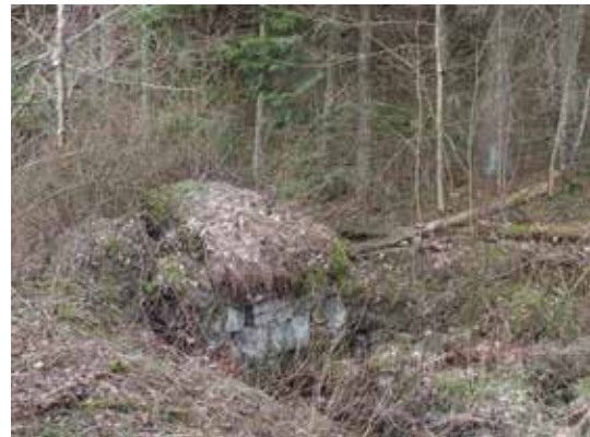
Purossa oleva harmaakivi- ja betonirakenne on sammaloitunut ja sen päällä kasvaa vesaikkoa.
