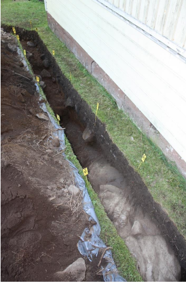
Kuva 27. Kaivausojan eteläosa kaivettu pohjaan, kuvattu länsilounaasta. AKDG 4664:33
