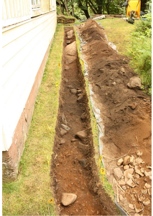
Kuva 21. Kaivausojan eteläosa tasossa 5, kuvattu koillisesta. AKDG 4664:25
