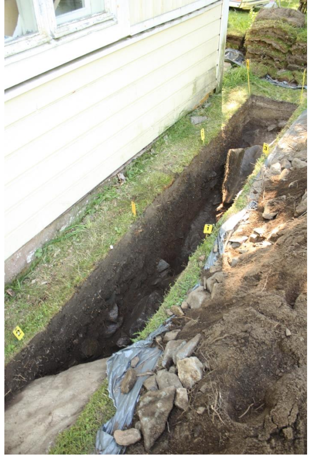
Kuva 28. Kaivausojan eteläosa kaivettu pohjaan, kuvattu pohjoisesta. AKDG 4664:34
