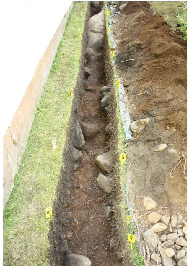
Kuva 26. Kaivausojan eteläosa kaivettu pohjaan, kuvattu koillisesta. AKDG 4664:32
