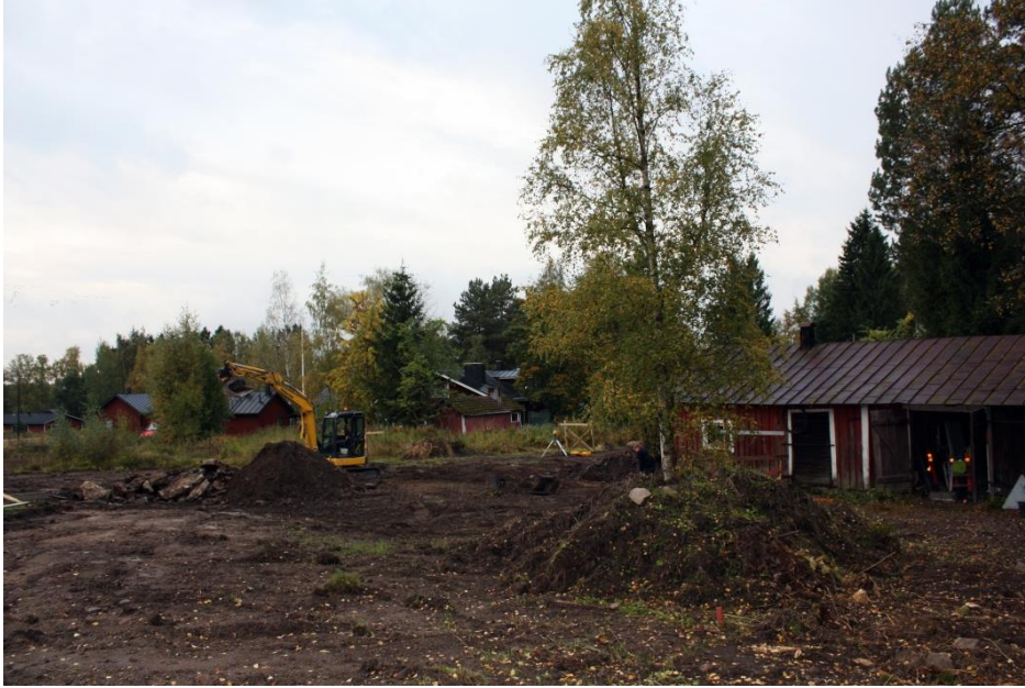
Kuva 3. Uuden asuinrakennuksen rakennuspaikka, kuvattu pohjoiskoillisesta. AKDG 4689:3
