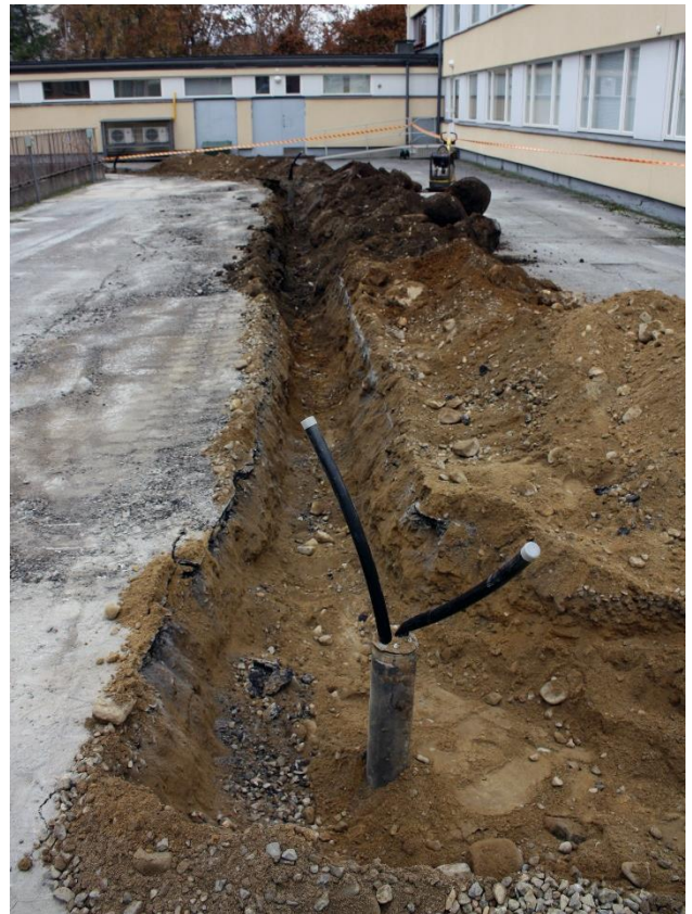
Kuva 12. Putkiojan keskiosa, jossa asfaltin alla oli täyttömaata ja pohjoisemmassa sekoittunutta hiekkaa, kuvattu lounaasta. AKDG 4691:8
