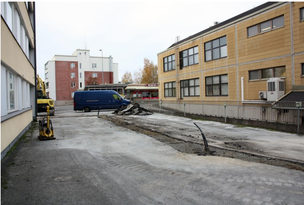
Kuva 3. Tulevan maalämpöpöjärjestelmän keskiosa, josta asfalttia on poistettu tulevan siirto-putkilinjan kohdalta. Kuvattu koillisesta. AKDG 4691:3
