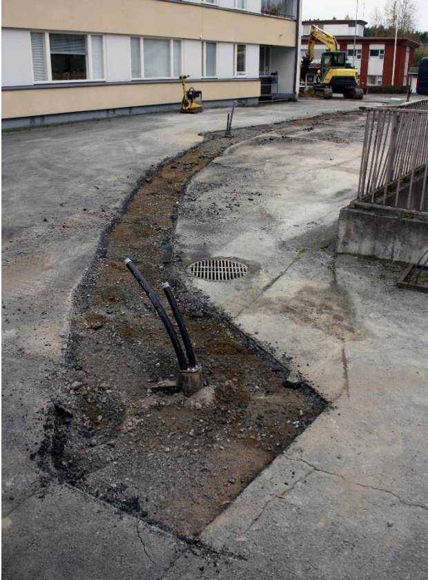
Kuva 9. Tulevan maalämpöjärjestelmän pohjoisin kaivo ja siitä lähtevä siirtoputken linja, jonka kohdalta on poistettu asfalttia. Kuvattu pohjoisesta. AKDG 4691:5
