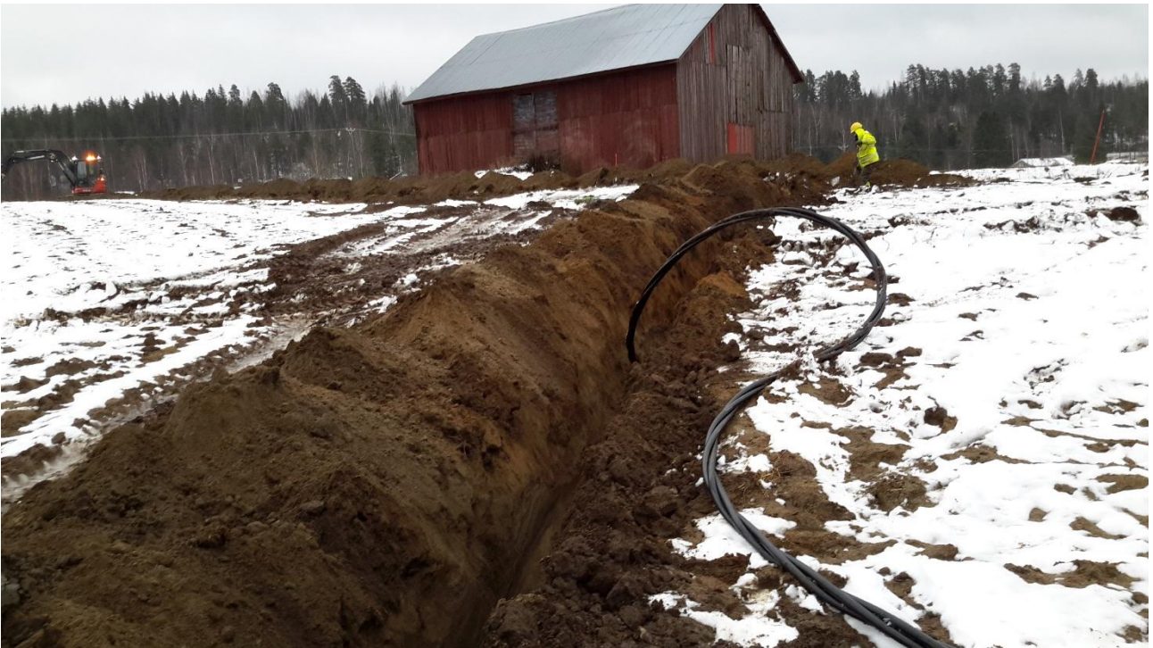
Valvottua maakaapelikaivantoa, joka kulkee pellon poikki itä - länsi-suunnassa. Kaivannon takana Tiihalantien laidalla sijaitseva vanha ulkorakennus ja taustalla metsäinen Keisarinharju. Kuvattu itäkoilliseen. Sami Raninen. KY 182: 1.
