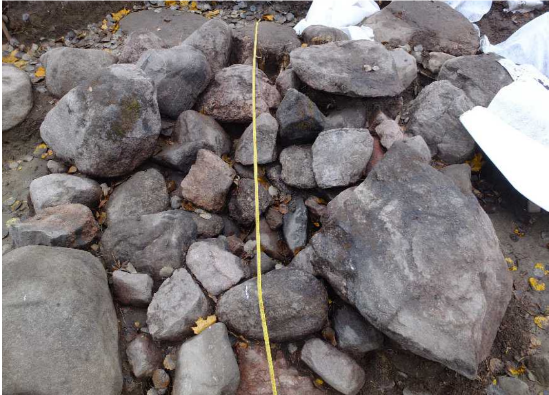
Kuva 138. Kuorin kivirakenne. Mitta rakenteen keskellä leikkauksen a-b kohdalla. Kuvattu itään.
