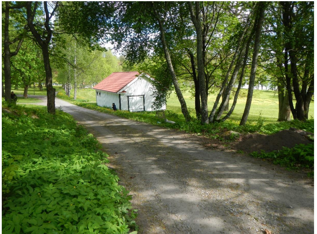
Kuva 3. Mielenkiintoisimmat havainnot tehtiin koekuopista 1, 6 ja 7, jotka sijaitsivat puutarhavajan länsipuolella Laukontien eteläpuolella. Markus Laurel kaivamassa koekuoppaa numero 8.
