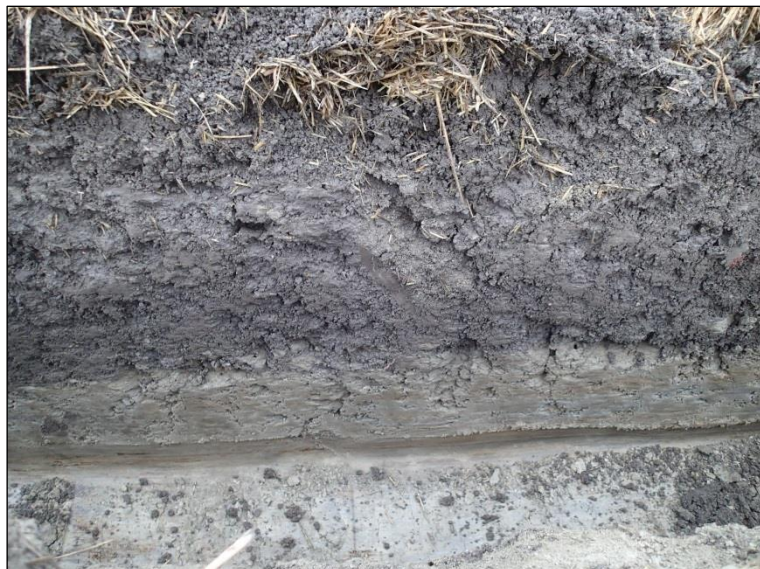
Kaapeliojan seinämää Järvenpääntien pohjoispuolella.
