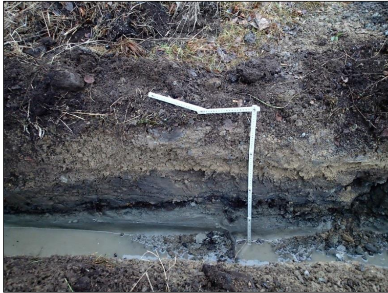
Kaapelikaivantoa n. 3 m Nisulan talon seinästä. Puunkuorikerros näkyy tummana viiruna.
