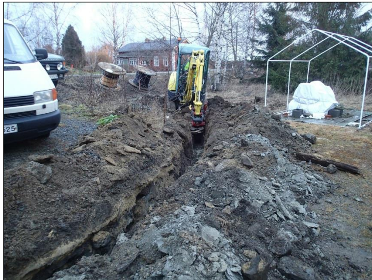
Kaapelikaivantoa n. 7 m etäisyydeltä Nisulan seinästä ja koilliseen kohti Järvenpääntietä.
