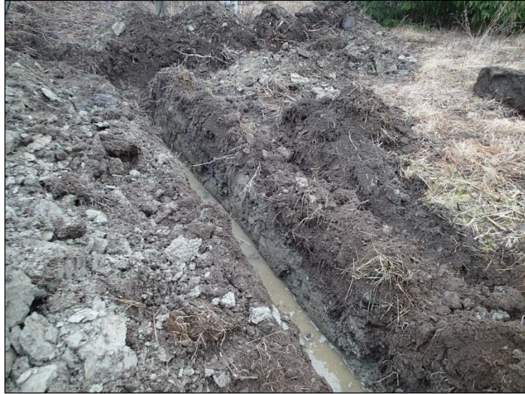
Kaapeliojaa heti pihaan tulevan tieluiskan itäpuolella.
