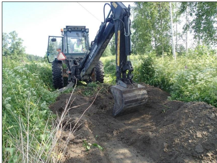
Sekoittuneita muokkaus- ja täyttökerroksia poistetaan kaivinkoneella.
