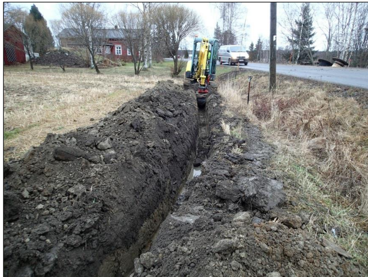
Kaapeliojaa Järvenpääntien pohjoispuolella
