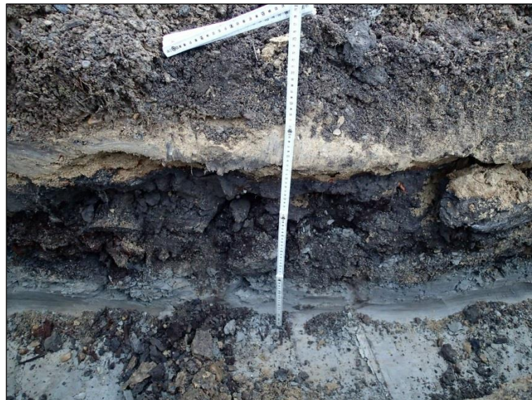
Pihalle tulevan tieluiskan kohta – päällä betonilaatta ja alla kivimurskaa.
