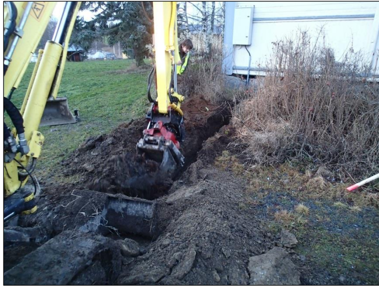
Kaapelikaivantoa Nisulan kupeessa, länteen.
