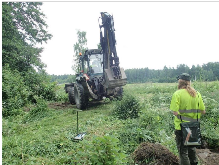
Sekoittuneita muokkaus- ja täyttökerroksia poistetaan kaivinkoneella.
