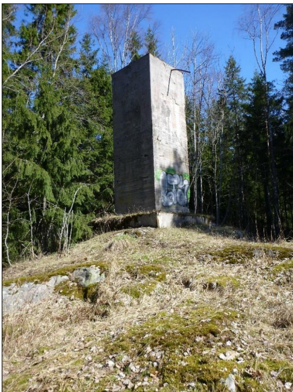
Jorvaksen vanha vesitorni Kuvattuna pohjois-koilliseen.
