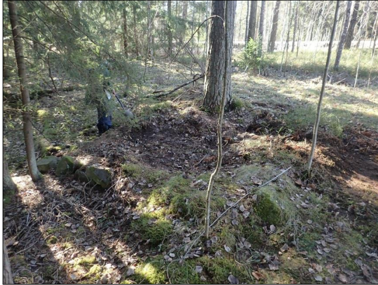
Rakennuksen perusta kaakosta, koekuoppien täyttämisen jälkeen.
