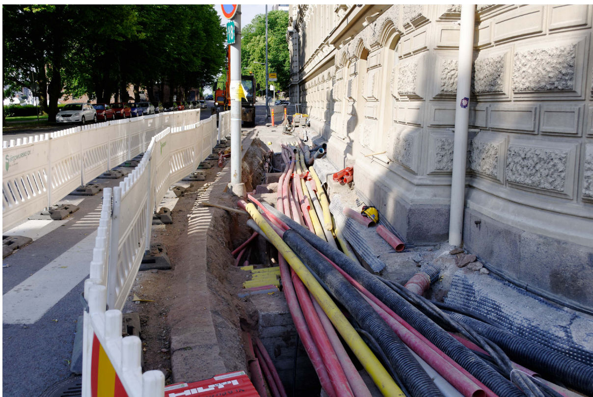
Kuva 2. Linnankadun puoleisen jalkakäytävän kohta on niin täynnä erilaista kunnallistekniikkaa ja rakenteita että kaivaminen onnistui vain imuroimalla. Rakennuksen massiiviset paalutusanturat ulkonevat noin 3 m kivijalasta. Kuva Markus Kivistö.
