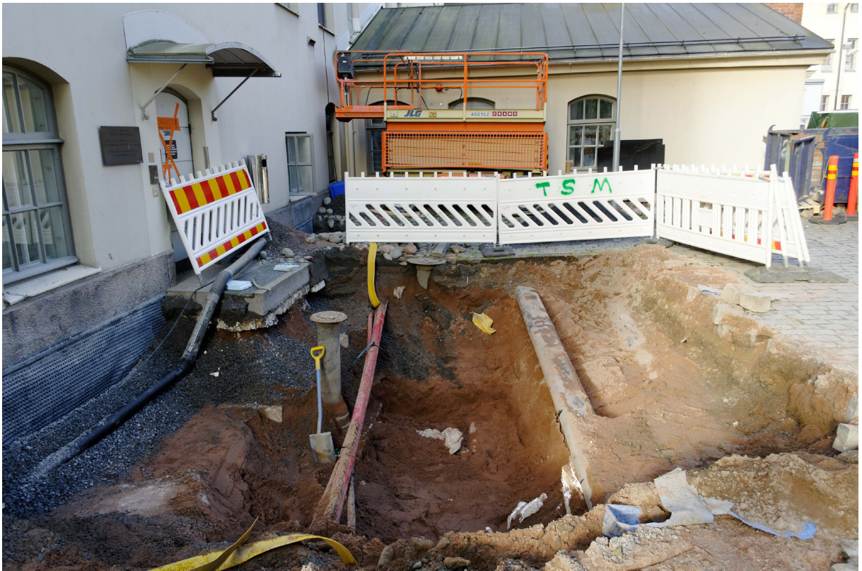
Kuva 3. Kaukokylmäkaivannon uuden linjauksen kohdalla maaperä oli täynnä kunnallistekniikkaa: oikealla on kaksi vanhaa kaukolämpöputkea ja keskellä kulkee sadevesiviemärien putkia. Kaikki vanhemmat rakenteet ja kerrokset ovat paikalta tuhoutuneet. Kuva Markus Kivistö.
