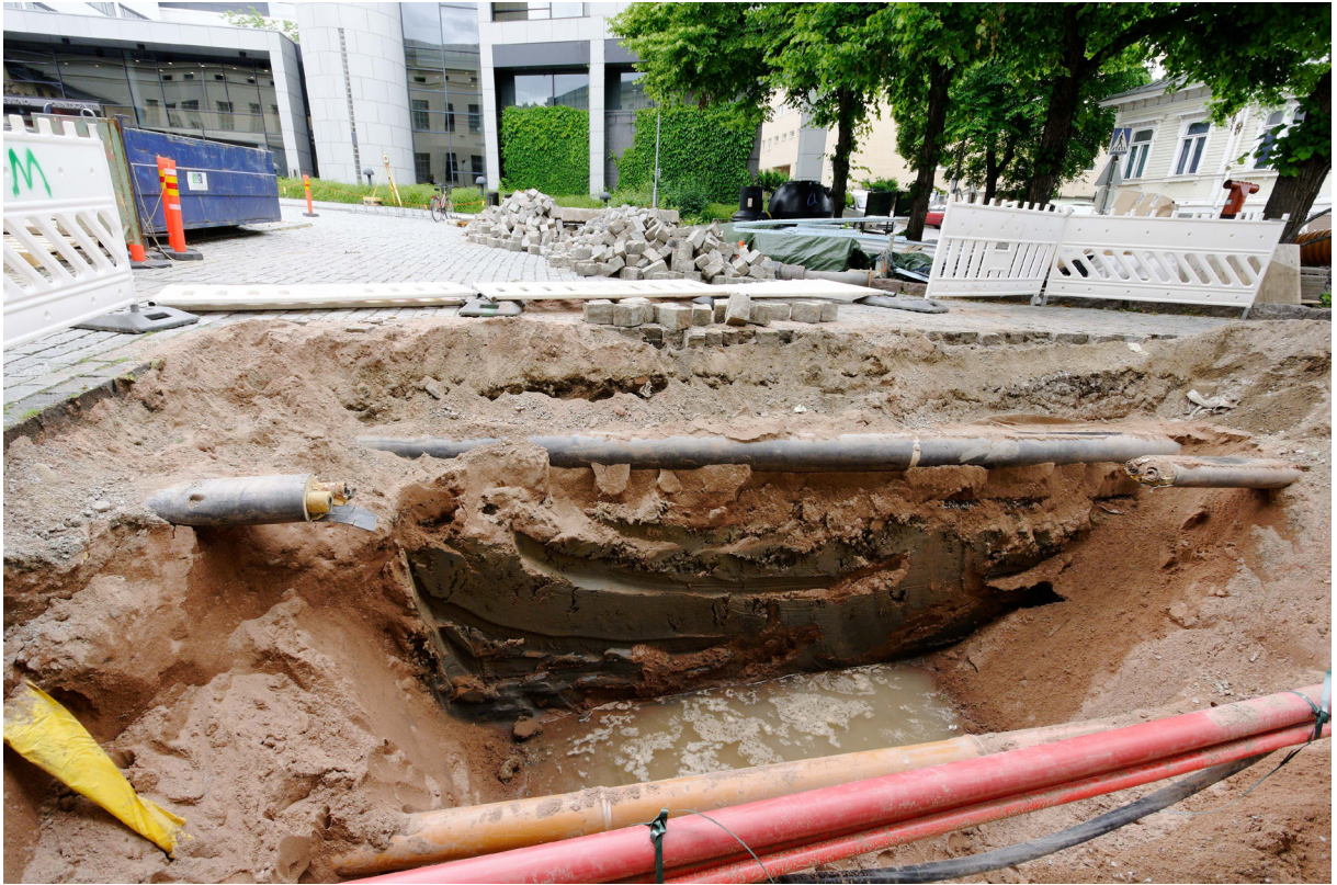
Kuva 4. Kaivannon pohjoisprofiilissa kaukolämpöputkien alla näkyy luontainen pohjasavi, jonka pintakorkeus on 3.13 – 3.35 m mpy (N2000). Vanhemmat kerrokset ovat tuhoutuneet kunnallistekniikkaa rakennettaessa. Kuva Markus Kivistö.
