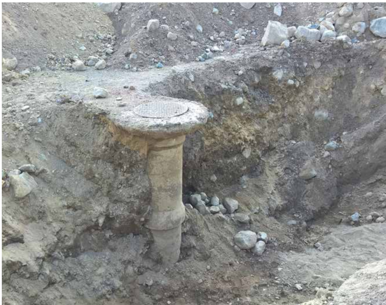
Kuva 1. Kaivanto 1 kasarmipihan kaakkoisosassa. Eteläinen profiili ja betonikaivo. N. Syyskuu 2015. KU.
