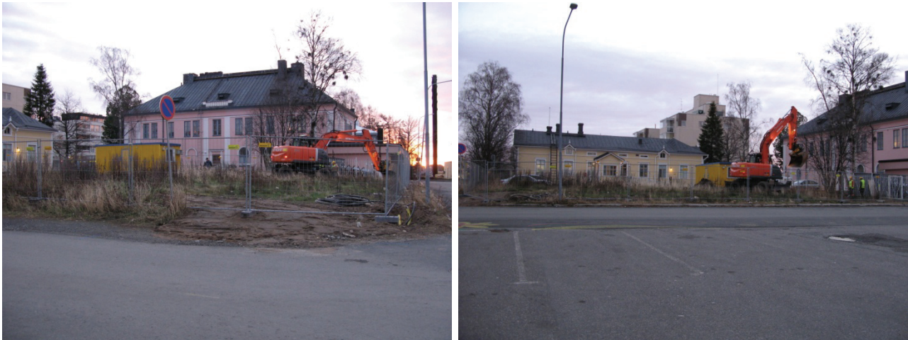
Yleiskuvia tontista ennen kaivun aloittamista. Vasemmanpuoleinen on otettu Eliaksenkadun ja Välikadun risteyksestä, oikeanpuoleinen Välikadun suuntaisesti, kadun toisella puolella olleelta parkkialueelta. Keltainen puurakennus on Avelan talo, ja vaaleanpunainen kivitalo on vanha Yhdyspankin talo, jossa nykyisin toimii Handelsbanken. AKDG 4495:1 ja 2.
