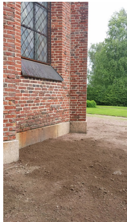
Kuva 19: MuTu116003Dg_006. Koekuoppa 1, peitetty kaivanto. S. Kuva J.L.
