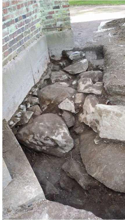
Kuva 6: MuTu116003Dg_008. Koe-kuoppa 2, laajennettu kaivanto. N. Kuva: J.L.
