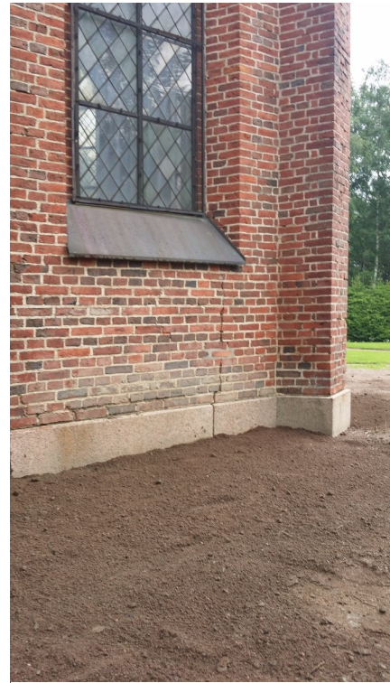
Kuva 17: MuTu116003Dg_027. Koekuoppa 3, peitetty kaivanto. SW. Kuva: J.L.
