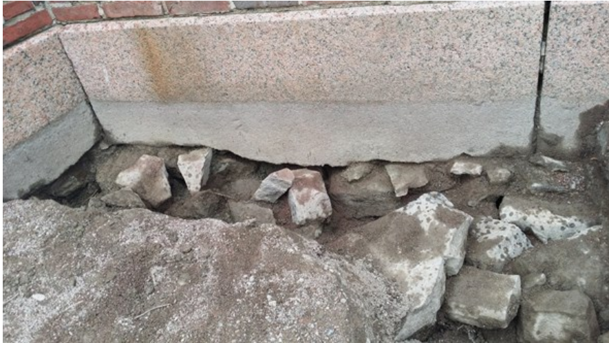
Kuva 13: MuTu116003Dg_023. Koekuoppa 3, rikkonainen kivirakenne. S. Kuva: J. L.
