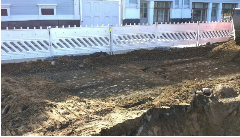
R8 kiveys esillä tasossa Rantakadulla kadun luoteis-/länsireunalla. Etualalla kaivanto 3, eli Rantakadun länsireunaan kaivettu hulevesiputkikaivanto. AKDG4273:342.
