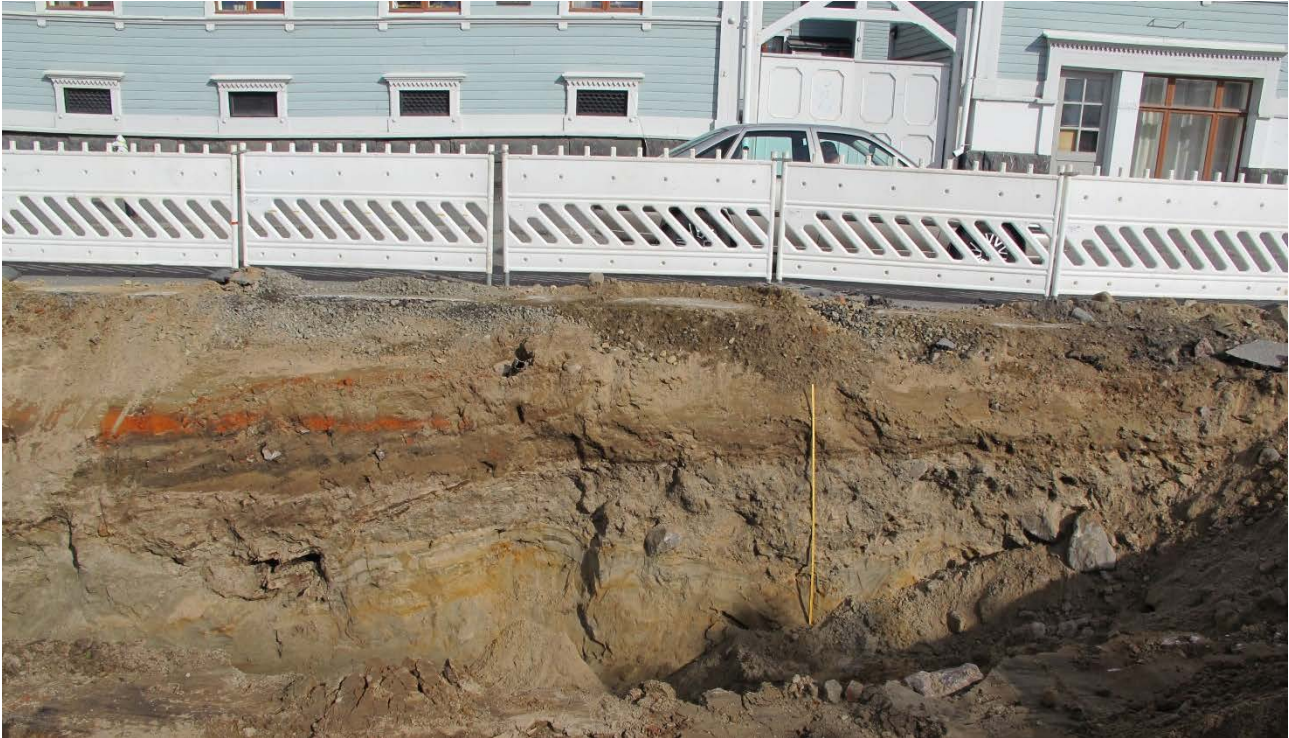
Profiilikuva kaivannon "4" itäseinästä. Kuvassa erottuu pohjamaan SY16 kerroksellisuus ja sen pinnan nousu Rantakatua etelään päin mentäessä. Kuvan vasemmassa reunassa on R28 viemärikotelorakenne ja sen kaivanto L29. Rakenteen yläpuolella erottuu selkeänä SY26 tiilikkerros jonka alla on kerroksellinen yksikkö, jolle ei annettu omaa yksikkönumeroa; on mahdollista, että kyseessä on anomalia kerroksessa SY30, joka erottuu kuvassa kerroksen alla. AKDG 4273: 147.
