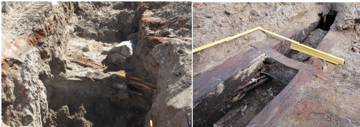
Vasemmalla: Kaivannossa 4 esiin tullut rakenteen R28 kaakkoispää. Pohjoisnuoli osoittaa kuvassa hiukan vinoon, kohti luodetta. Oikealla: Edellisessä kuvalla olevan putken sisässä ollut poikittainen tukilauta. AKDG 4273: 136 ja 144.
