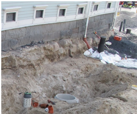
Yksityiskohta kuvasta AKDG 4273:326. Arkkitehtuuriosaston kivijalka ja sen kiviperustus.
