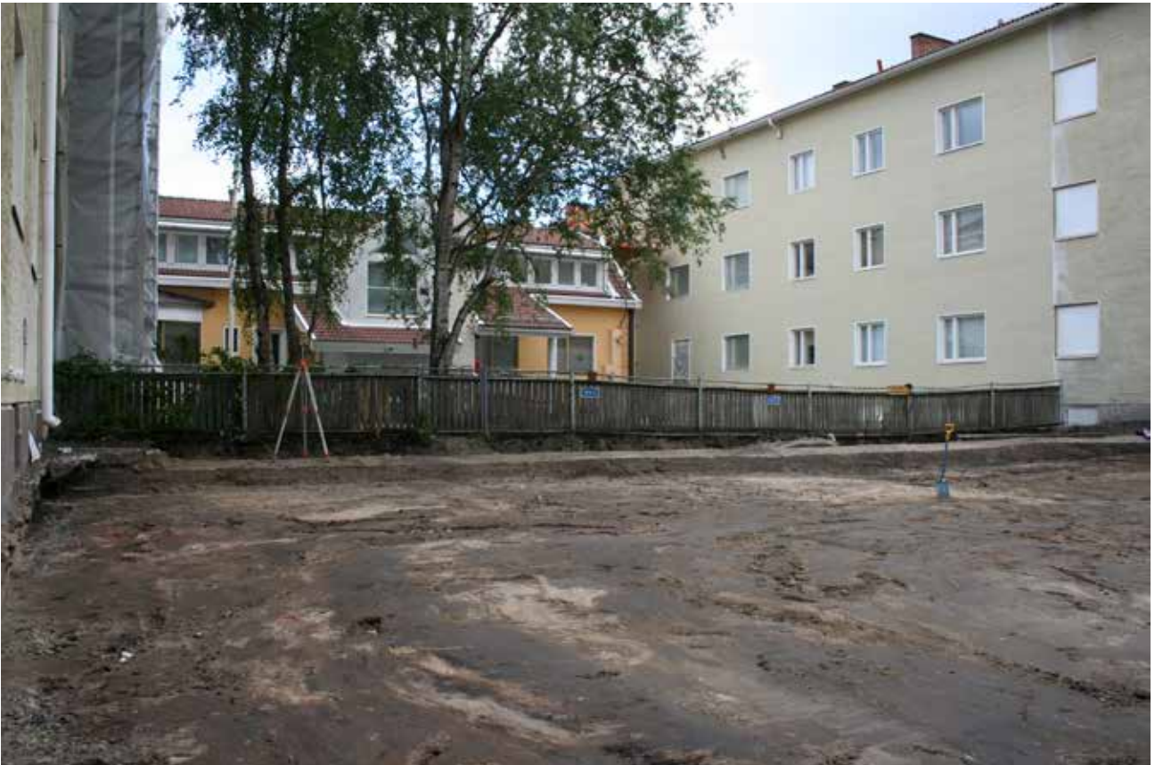
MuTu116015:2. Valvottu alue tavoitesyvyydessä, taustalla aidan edessä talojen väliin rakennettu maanalainen betonikanaali. (JH, lounaasta)
