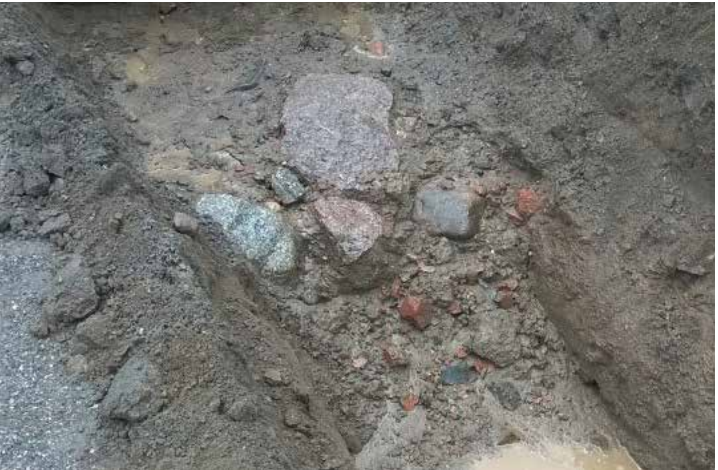
Kuva MuTu116006:2. Kaivannon keskiosasta esiin tullut pihakivetyys N. KU. Kesäkuu 2016.
