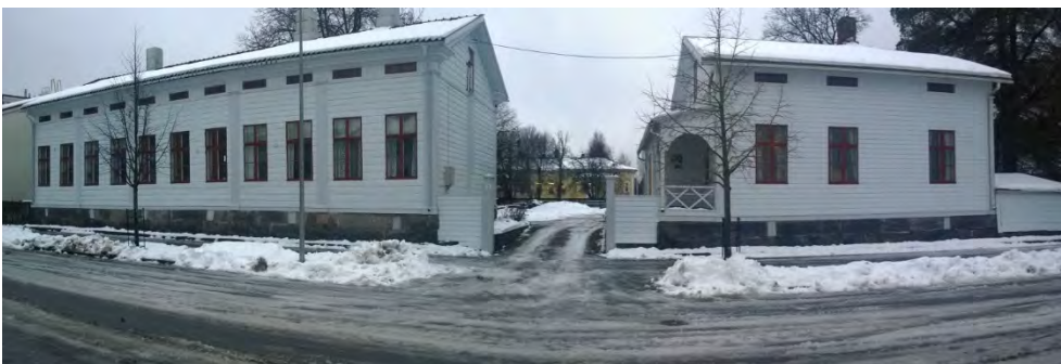
AKDG 4528_51. Kaksi vanhaa kivijalka- asuinrakennusta Porvarinkadun varrella, kiinteistö 89300202020046. Kuvaaja: P. Pesonen.
