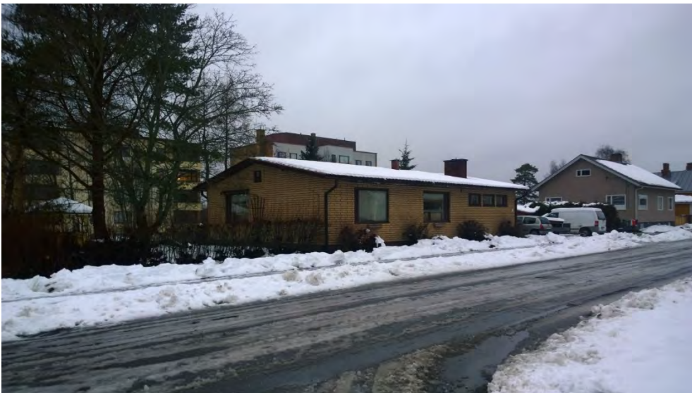
AKDG 4528_98. Tiilinen omakotitalo, kiinteistö 89300500240094. Kuvaaja: P. Pesonen.
