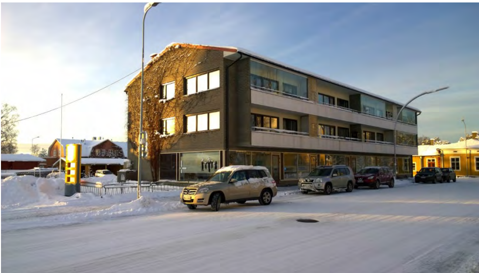
AKDG 4528_26. Kerrostalo osoitteessa Kirkkotie 1, kiinteistö 89300101040005. Kuvaaja: P. Pesonen.
