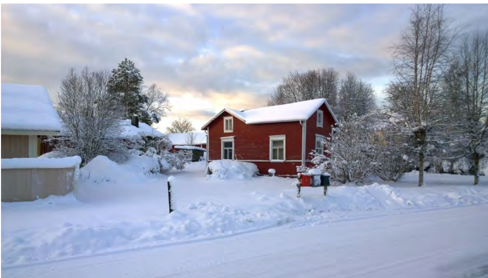
AKDG 4528_144. Vanha mökki osoitteessa Ratakatu 3, kiinteistö 89301111020002. Kuvaaja: P. Pesonen.
