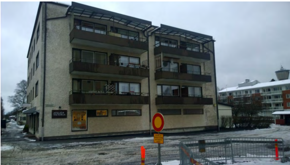
AKDG 4528_89. Kerrostalo, jonka alakerrassa Ateljee Victoria, kiinteistö 89300404130059. Kuvaaja: P. Pesonen.
