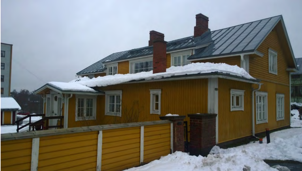
AKDG 4528_118. Vanha omakotitalo, kiinteistö 89300505080005. Kuvaaja: P. Pesonen.
