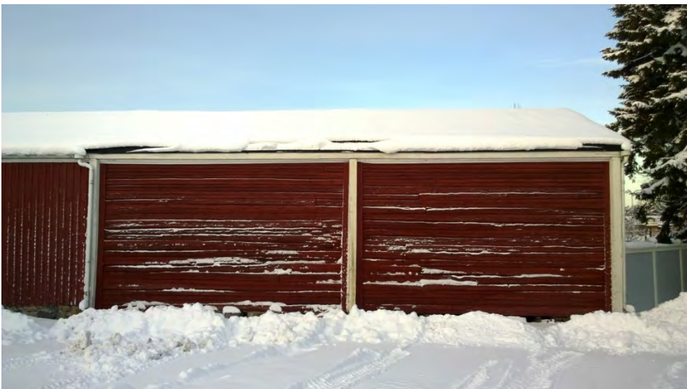
AKDG 4528_6. Viereisen tontin aitta triviaalikoulun sisäpihalta, kiinteistö 89300101010001. Kuvaaja: P. Pesonen.
