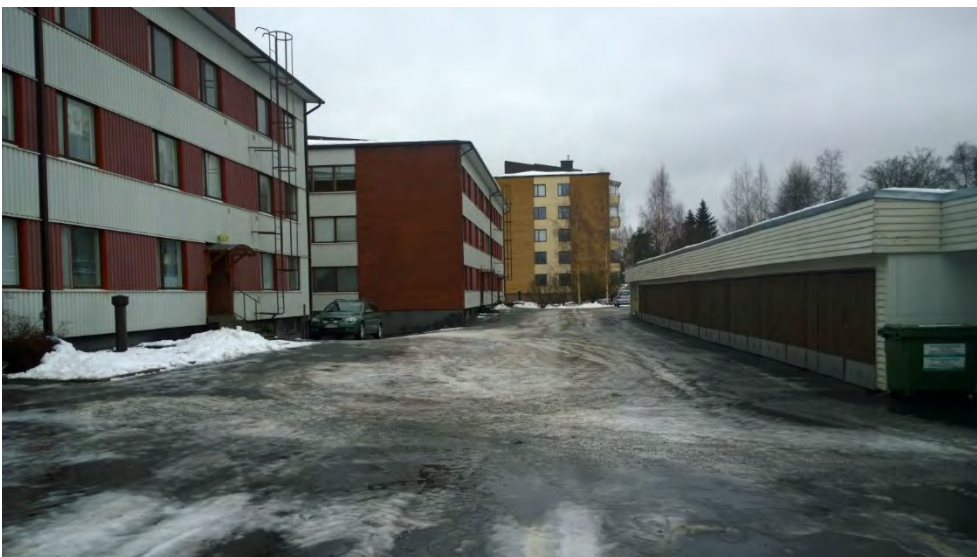
AKDG 4528_108. Sisäpiha, yhteinen viereisen kiinteistön kanssa, kiinteistö 89300505010079. Kuvaaja: P. Pesonen.
