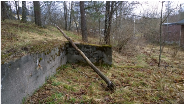
AKDG 4692:57. Betoninen rakenteen pohja, kaakosta. Kuvaaja: Petro Pesonen.
