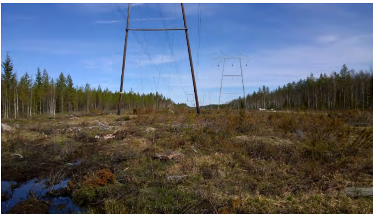
AKDG 4698:6. Kotikorvennevan tienoon linjausta, lounaasta. Kuvaaja: Petro Pesonen.
