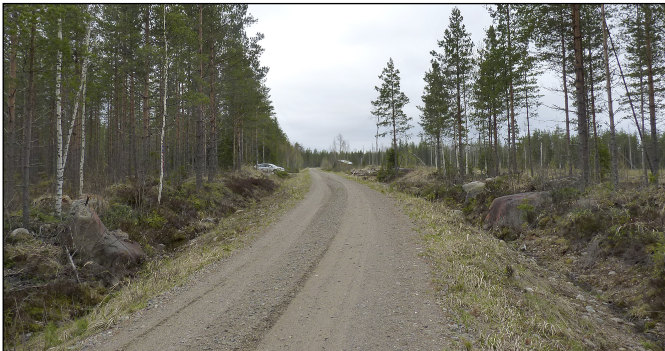
Kuva 9. Tuulivoimaloiden sijoittelualueelle johtavan sähkönsiirtolinjan alkupäätä. Kuvattu pohjoisluoteesta.
