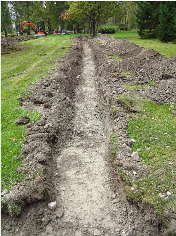
Kuva 4. DIGMAV2016009: 5. 1. kuivatusputken kaivanto luoteesta lukien puhtaaseen pohjamaahan asti kaivettuna. Koillisesta. Eetu Sorvali.
