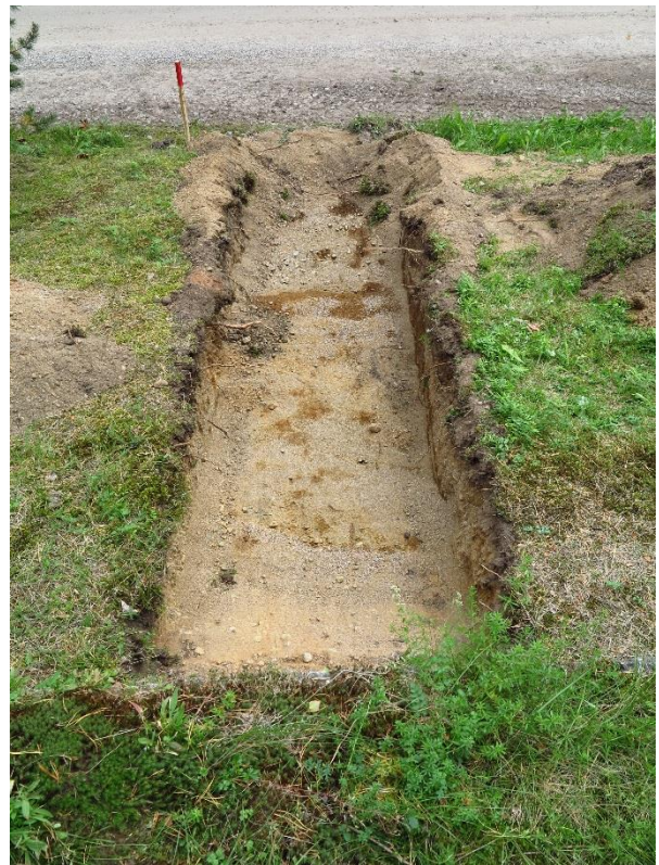
Kuva 5. DIGMAV2016009: 3. Purkuputken kaivanto puhtaaseen pohjamaahan asti kaivettuna Särkängtien ja hautausmaan kiviainan välissä. Lännestä. Eetu Sorvali.
