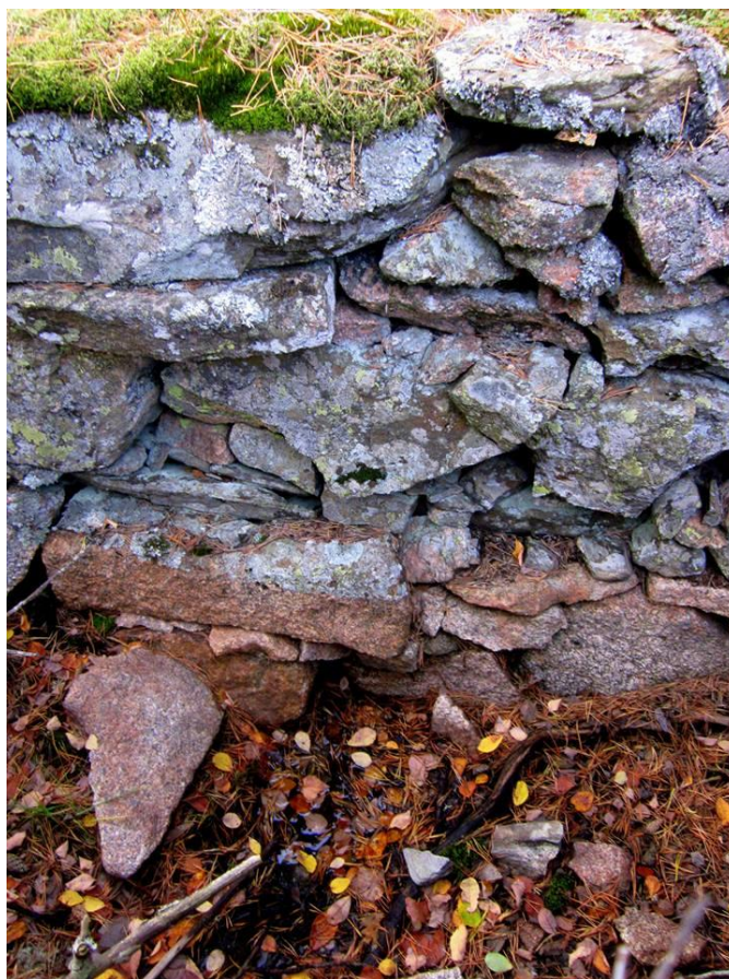
AKDG 4696:3 Telegrafberget 2. Kallmurad väggkonstruktion i den södra stenkonstruktionens södra vägg. Väggens nedre del blottats av rotvältan. Från söder. Foto Jan Fast.
