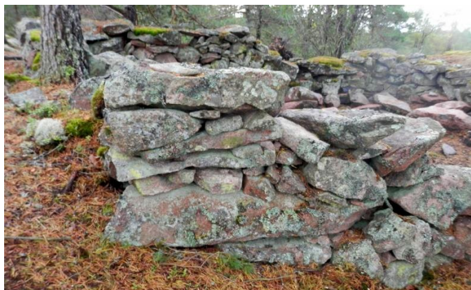
AKDG 4696:8 Konstruktionsdetalj. Välbevarad kallmurad murkonstruktion i det nordöstra hörnet av den södra stensättningen. Foto Jan Fast.
